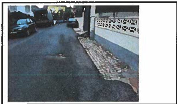
Reparação de pavimento betuminoso
