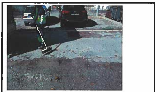
Reparação de pavimento betuminoso
