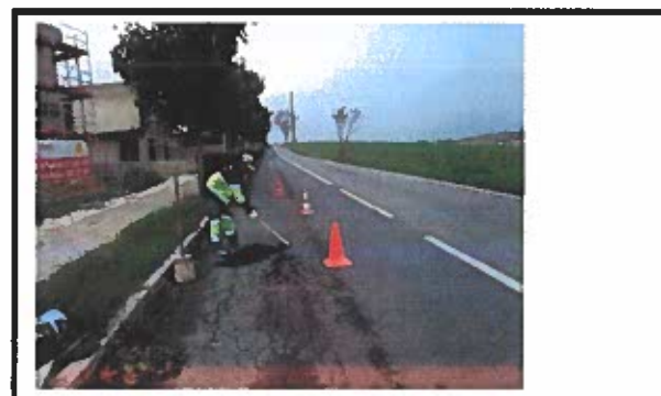
Reparação de pavimento betuminoso
