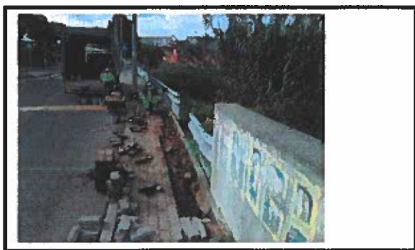
Reparação de pavimento em pavê
