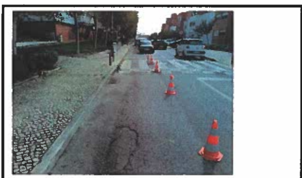
Reparação de pavimento betuminoso
