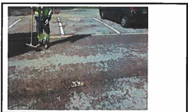
Reparação de pavimento betuminoso
