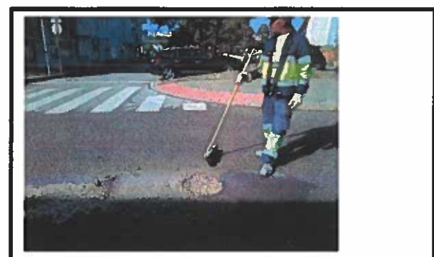
Reparação de pavimento betuminoso
