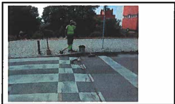
Reparação de pavimento betuminoso
