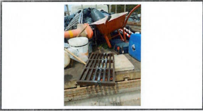
Reparação de grelha de sarjeta
