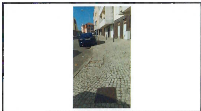
Reparação de calçada
