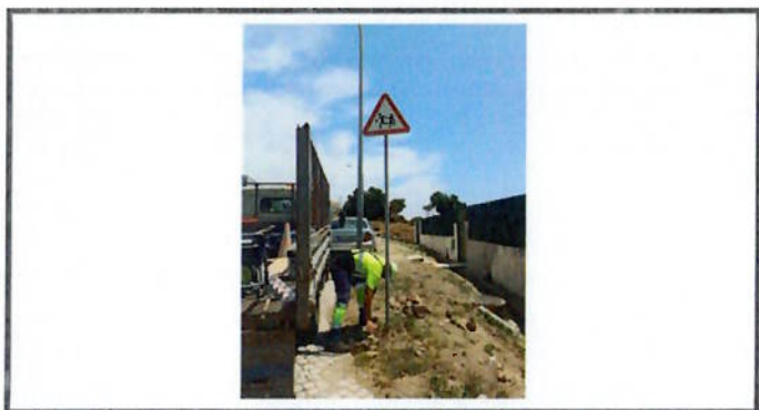
Substituição de Sinalização Vertical
