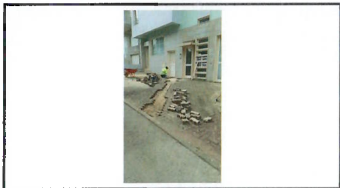
Reparação de calçada
