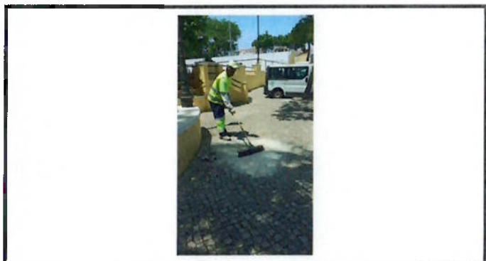
Reparação de calçada
