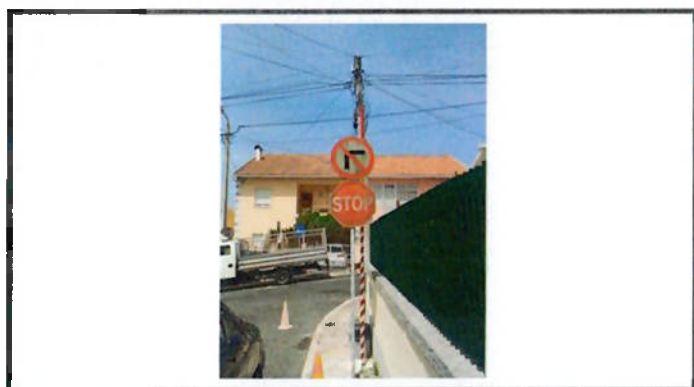
Substituição de sinalização Vertical
