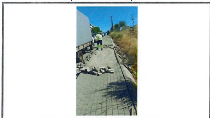
Reparação de calçada
