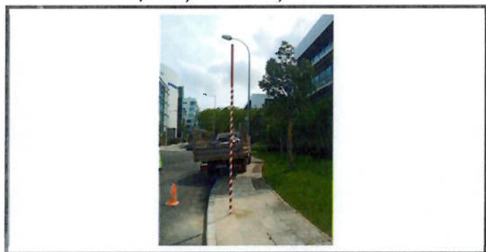
Substituição de sinalização vertical
