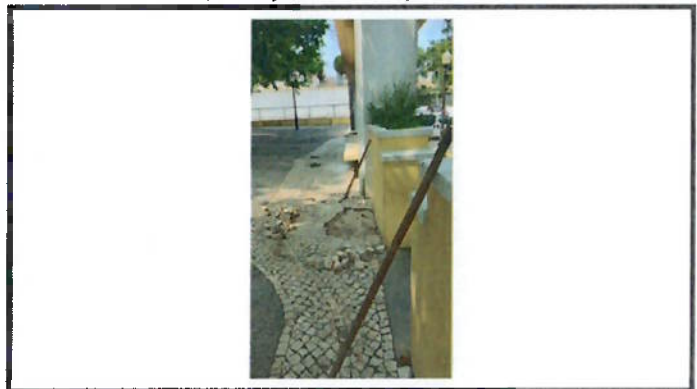
Reparação de calçada
