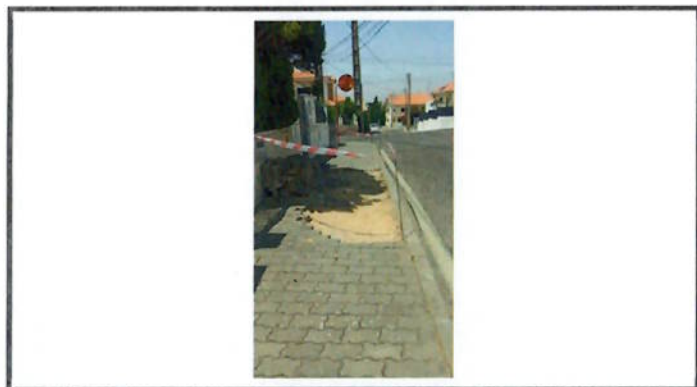
Reparação de calçada
