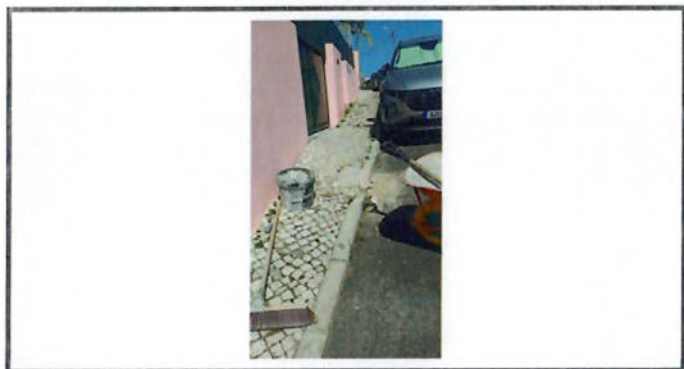
Reparação de calçada
