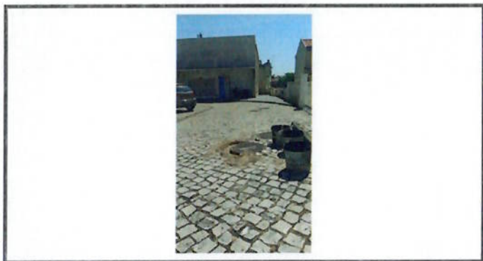
Reparação de calçada
