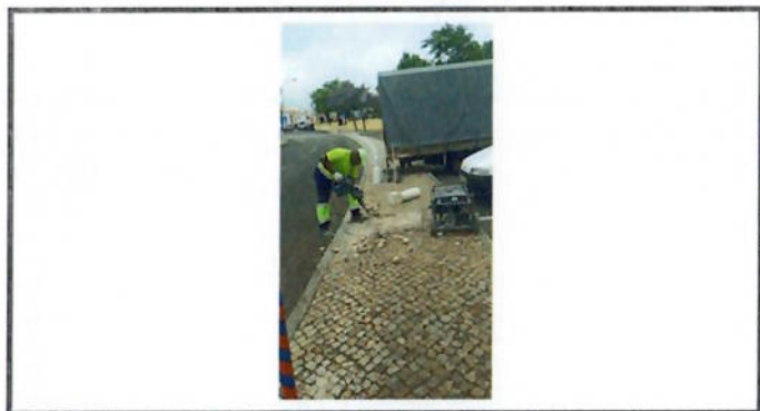
Reparação de pilarete
