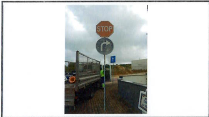
Substituição de sinalização vertical
