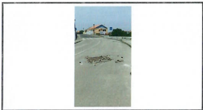
Reparação de pavimento
