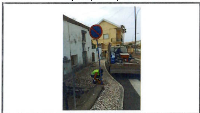
Substituição de sinalização vertical
