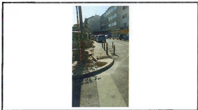
Reparação de pilarete
