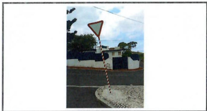
Recolocação de Sinalização vertical
