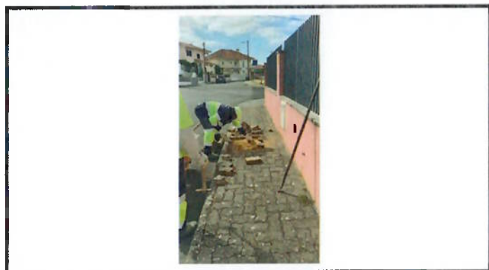
Reparação de calçada
