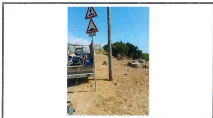
Substituição de Sinalização Vertical
