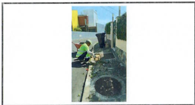
Reparação de calçada
