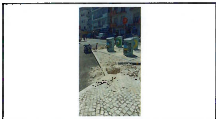
Recolocação de pilaretes
