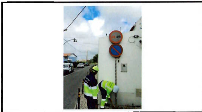
Substituição de sinalização vertical
