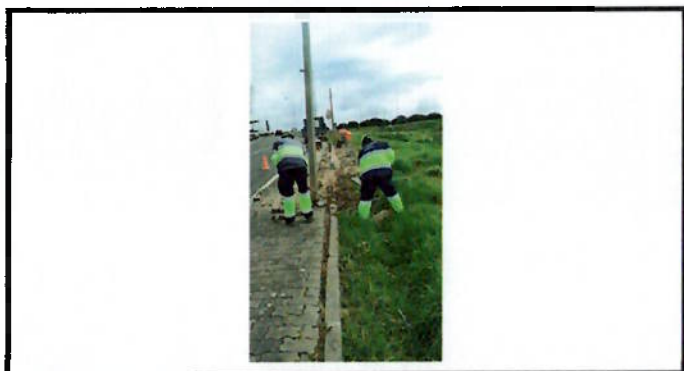
Reparação de calçada
