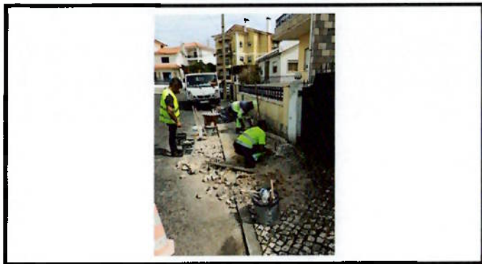
Reparação de calçada
