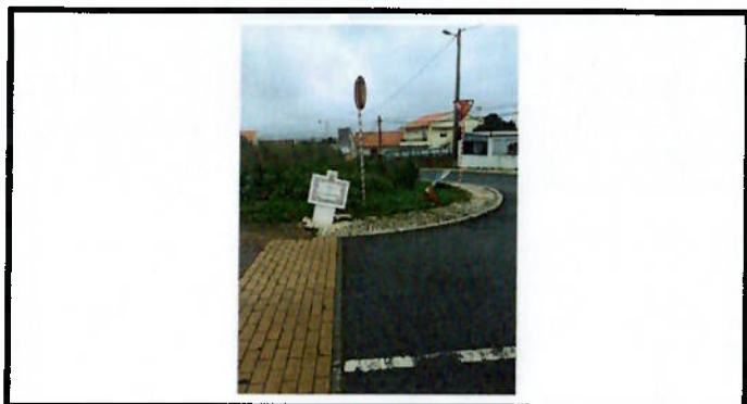
Reparação de placa toponímica
