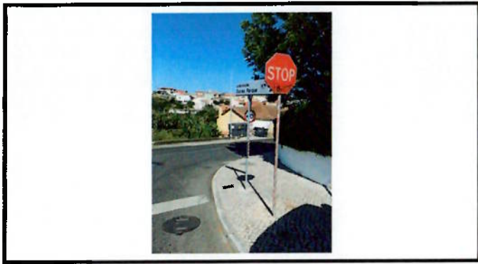
Substituição de sinalização vertical
