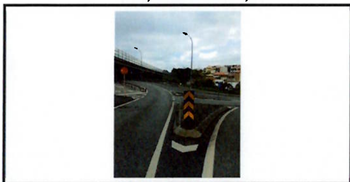
Recolocação de sinalização vertical
