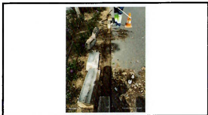
Reparação de Lancel
