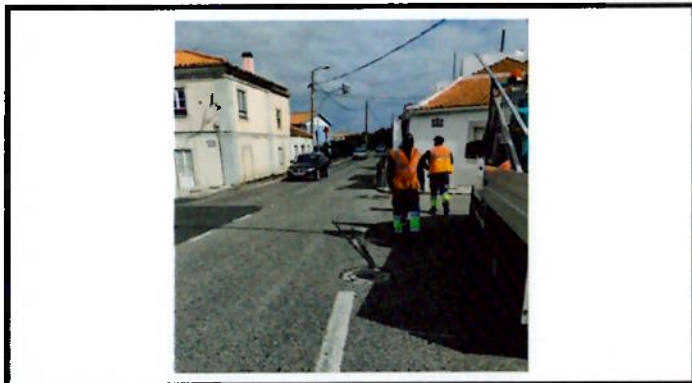
Pintura de sinalização horizontal
