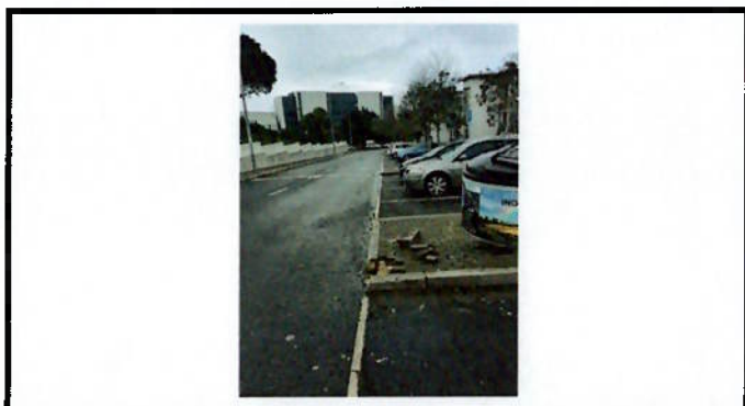
Reparação de calçada
