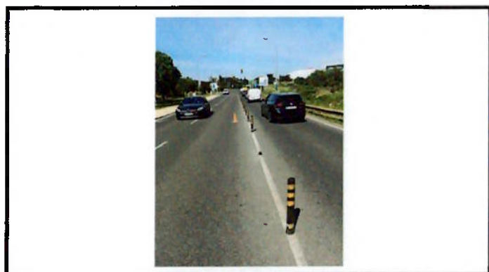
Recolocação de balizador
