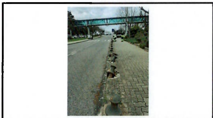
Recolocação de pilaretes
