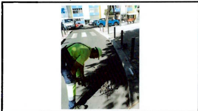
Substituição Lancil "sarjeta"
