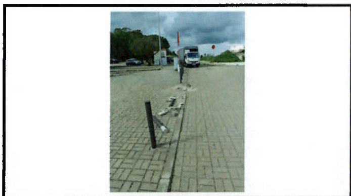
Recolocação de pilaretes
