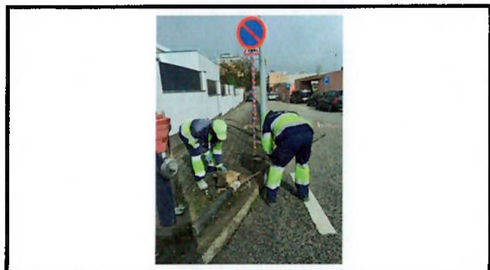
Recolocação de sinalização vertical
