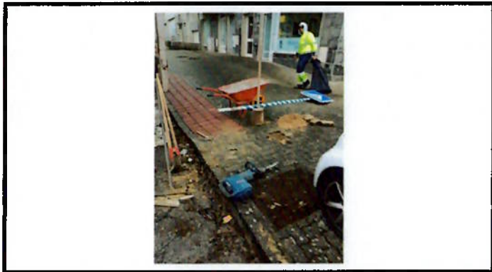
Recolocação de Sinalização vertical
