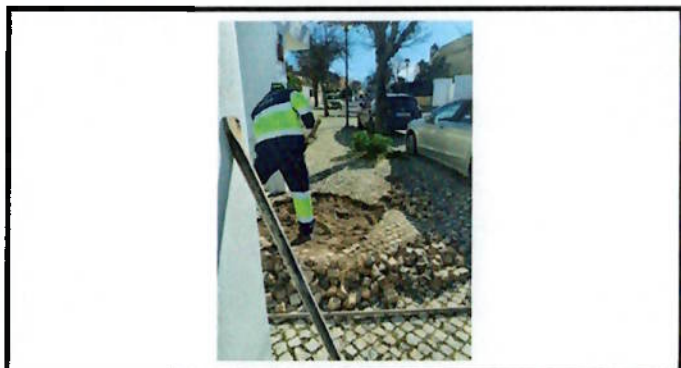
Reparação de calçada
