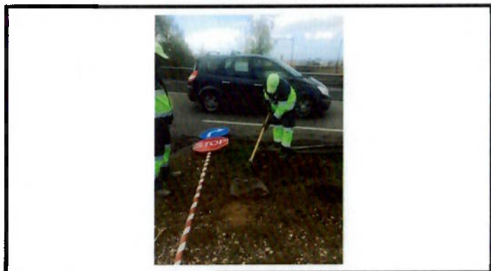
Substituição de Sinalização vertical
