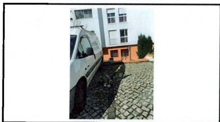
Recolocação de pilarete
