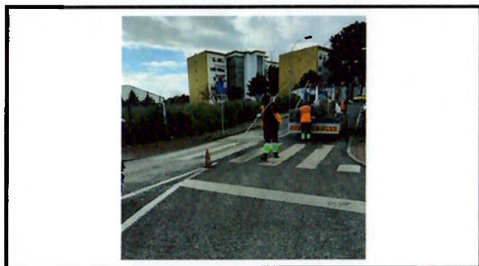
Pintura de Sinalização Horizontal
