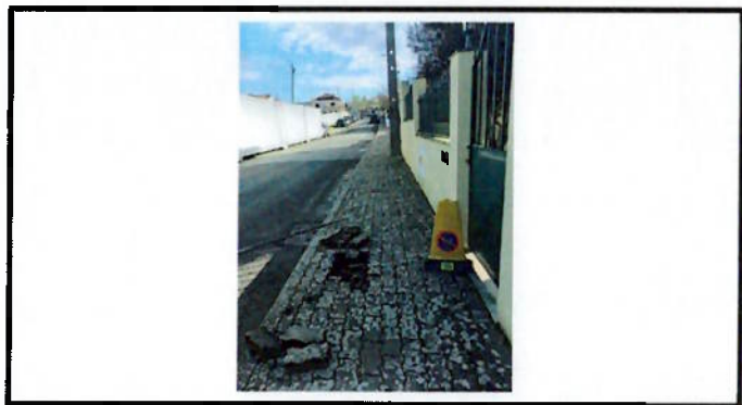
Reparação de calçada
