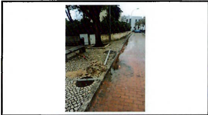
Colocação de espelho parabólico
