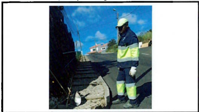
Substituição Lancil "sarjeta"
