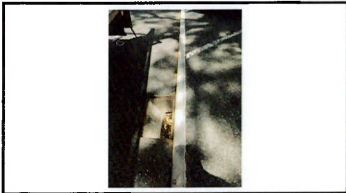
Reparação de grelha de sarjeta
