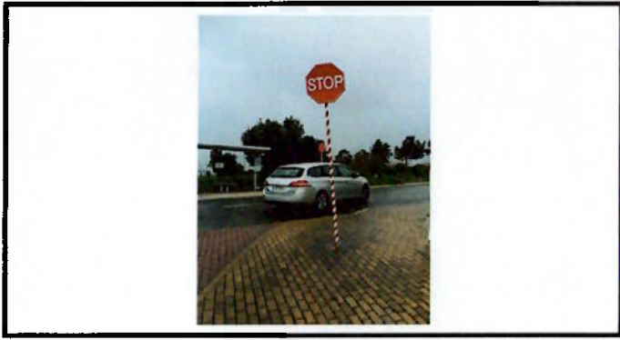
Recolocação de Sinalização vertical
