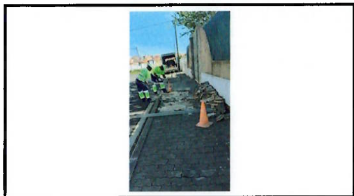
Reparação de calçada
