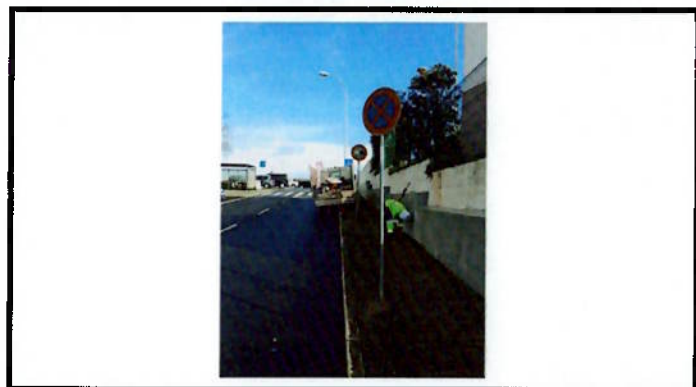
Substituição de sinalização vertical
