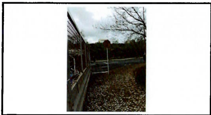
Substituição de sinalização vertical
