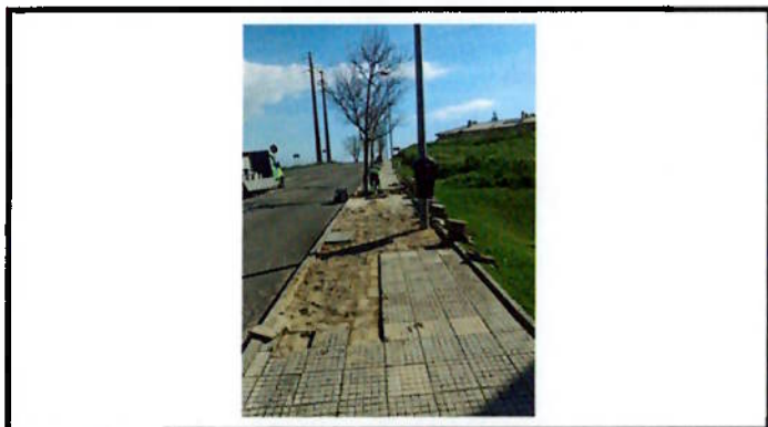
Reparação de calçada
