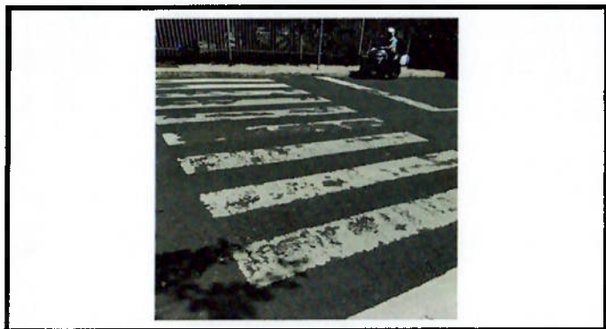
Pintura de Sinalização Horizontal
