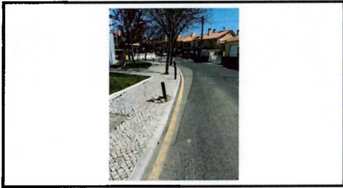
Recolocação de pilarete
