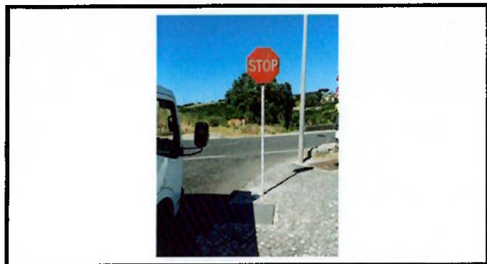
Substituição de Sinalização Vertical
