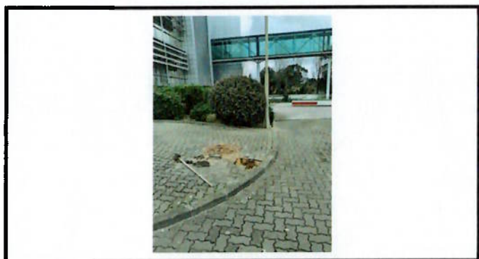
Recolocação de pilarete
