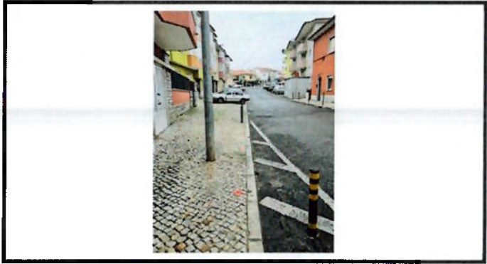
Colocação de Pilaretes
