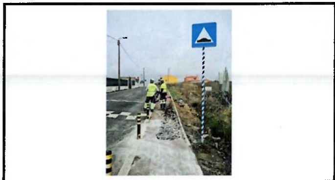
Pintura de Piso
