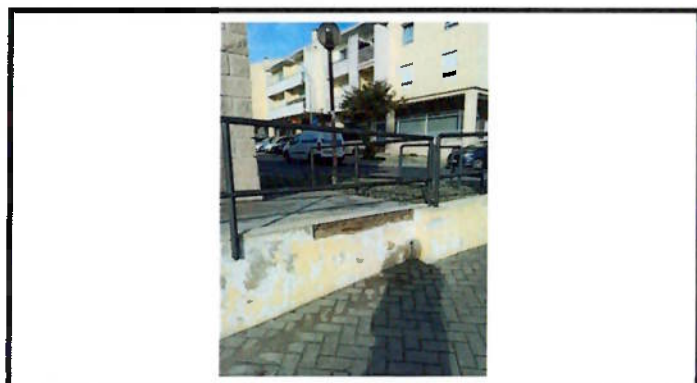
Reparação de murete
