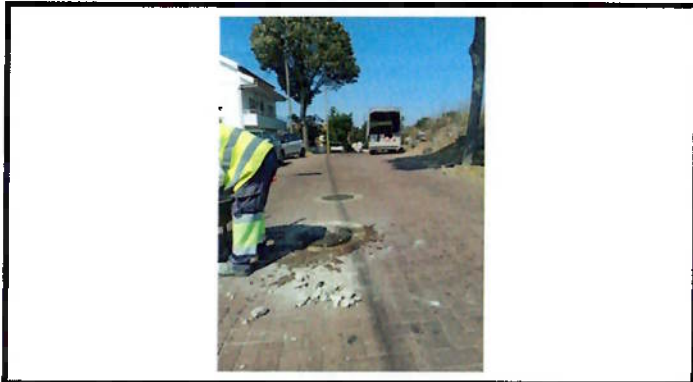
Reparação de tampa do esgoto
