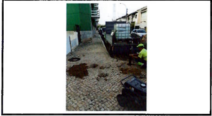
Colocação de Pilaretes
