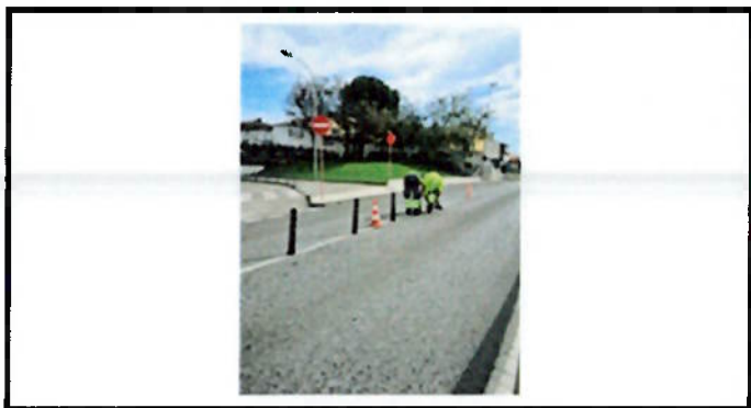
Substituição de balizadores
