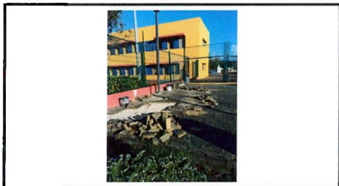
Reparação de calçada
