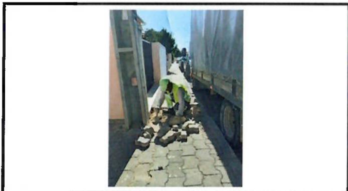
Reparação de calçada
