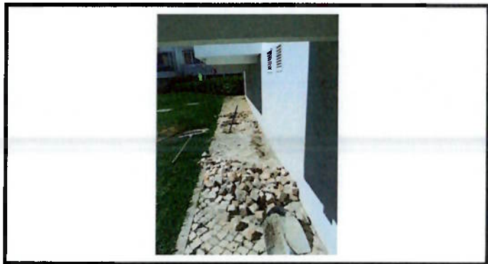
Reparação de calçada
