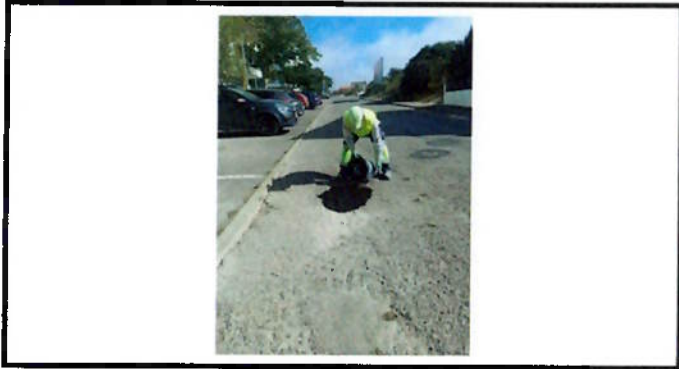
Reparação de Pavimento
