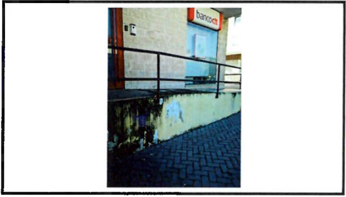
Reparação de pintura de murete
