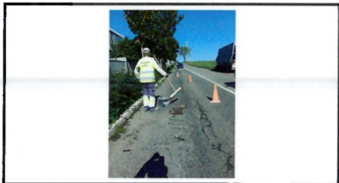
Reparação de pavimento
