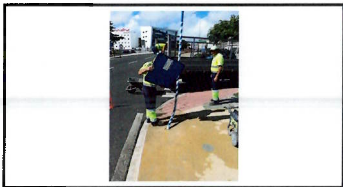
Substituição de sinalização vertical
