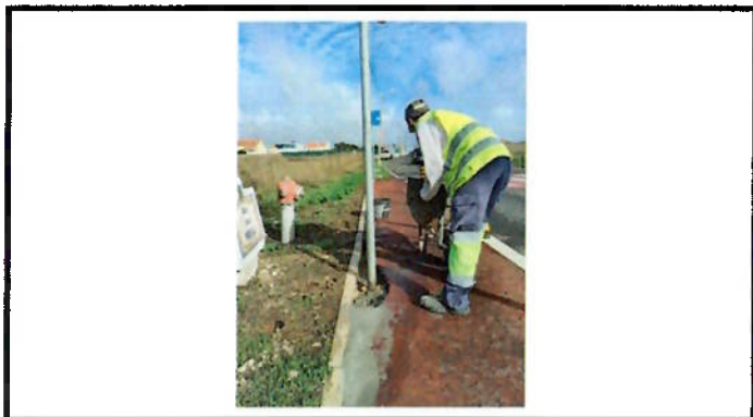
Reparação de piso
