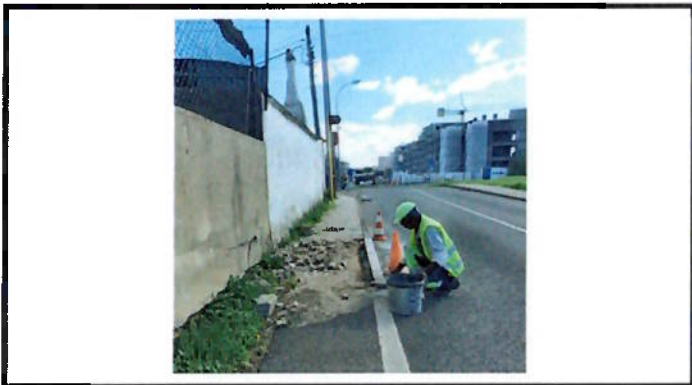
Reparação de calçada
