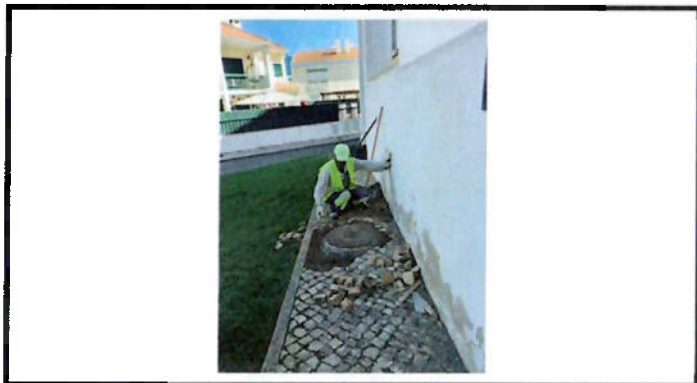
Reparação de calçada
