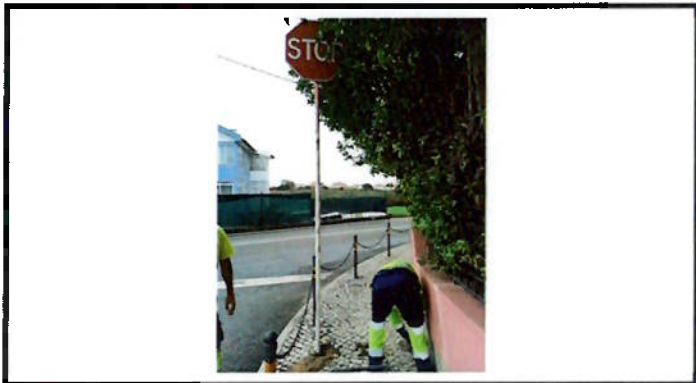
Substituição de Sinalização Vertical
