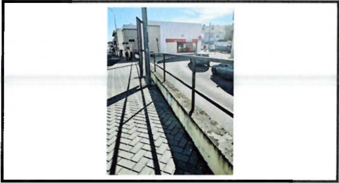
Pintura de murete
