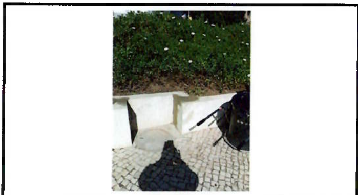
Reparação e pintura de murete
