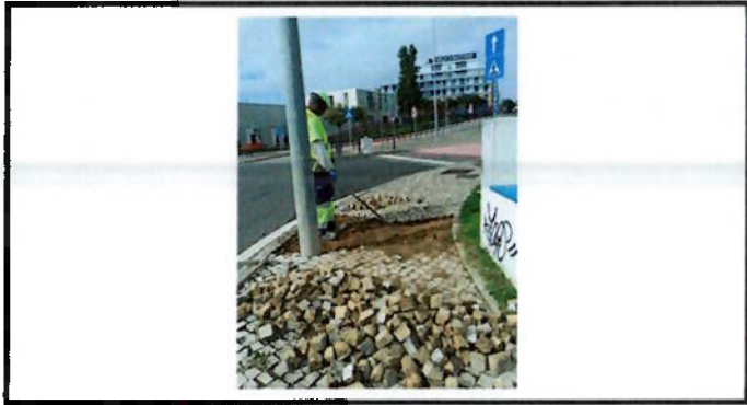
Reparação de calçada
