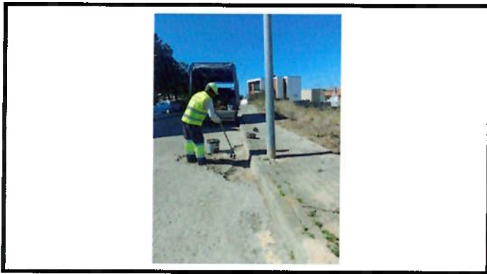
Reparação de pavimento
