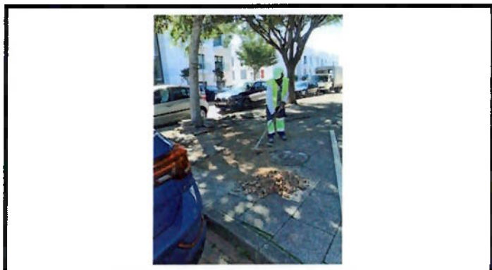
Reparação de calçada
