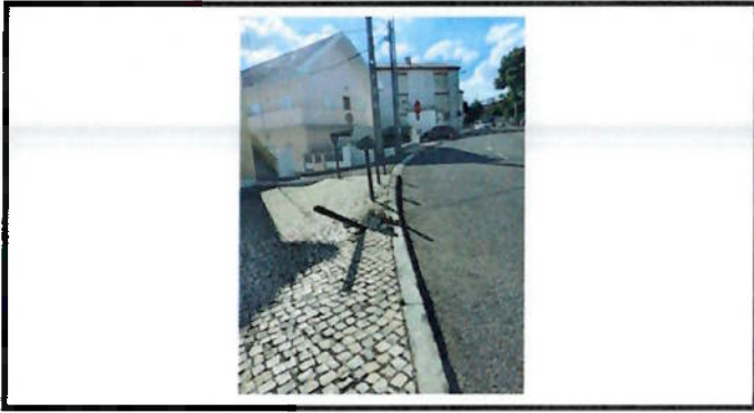
Recolocação de pilarete
