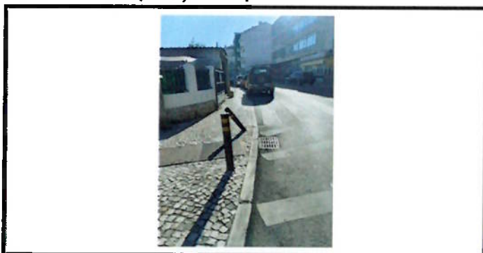
Reparação de pilarete
