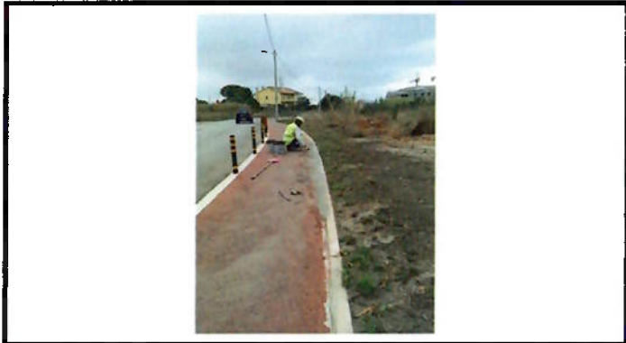
Reparação de piso
