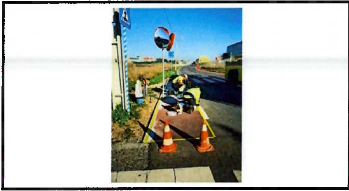
Pintura de piso
