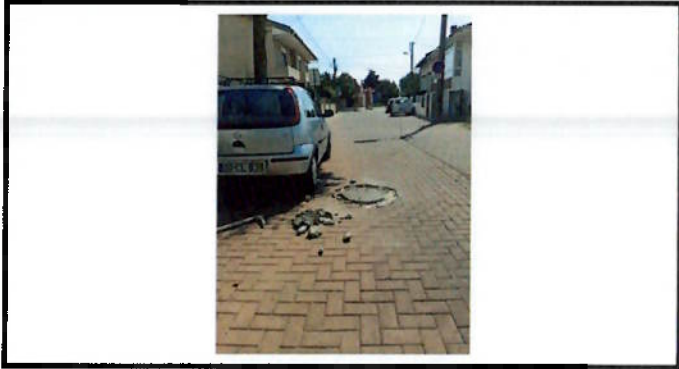
Reparação de tampa do esgoto
