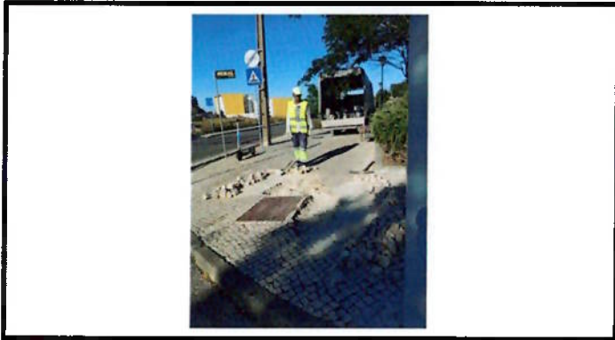
Reparação de calçada
