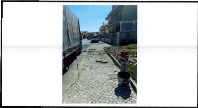
Reparação de calçada
