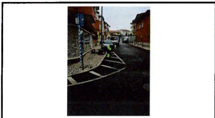
Colocação de balizadores
