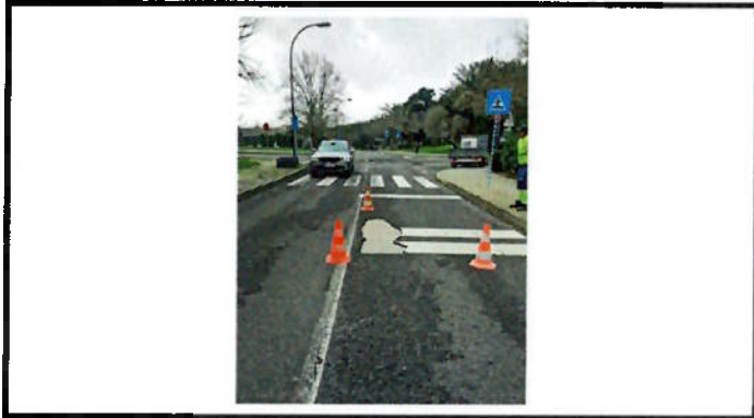
Reparação de pavimento
