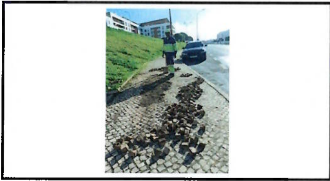
Reparação de calçada
