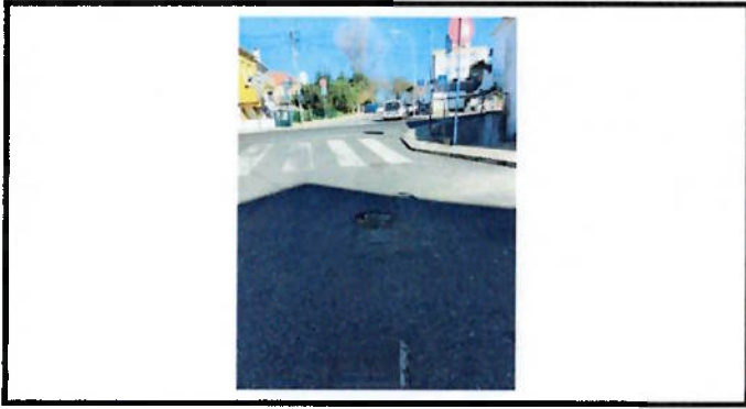
Reparação de pavimento
