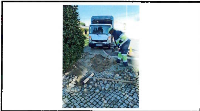
Reparação de calçada
