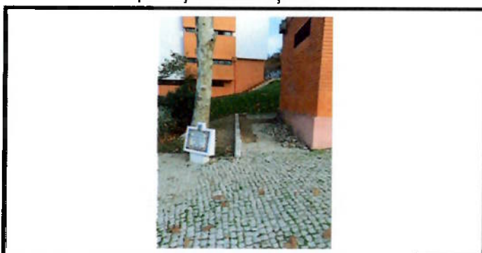
Reparação de calçada
