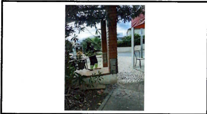
Reparação de Pilares
