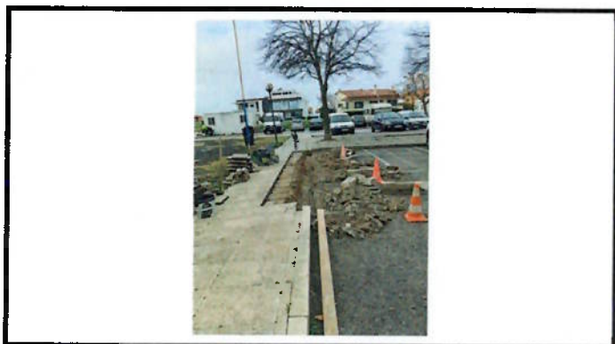
Reparação de calçada
