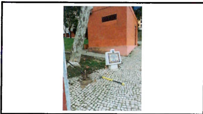
Reparação de calçada
