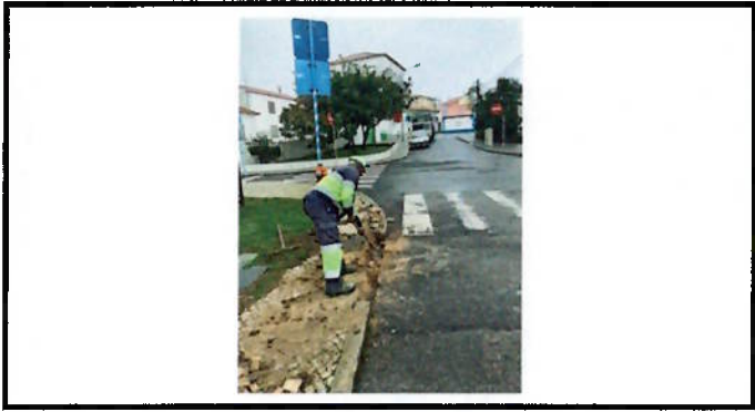
Reparação de calçada
