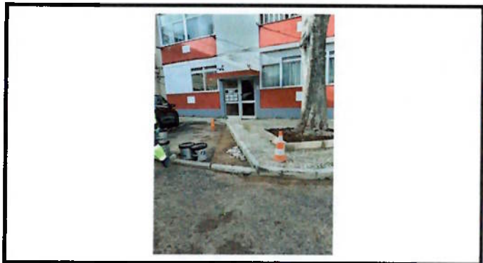
Reparação de pavimento
