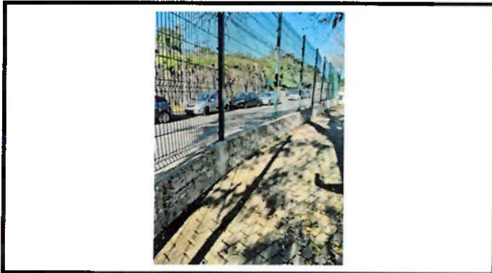
Pintura de muros
