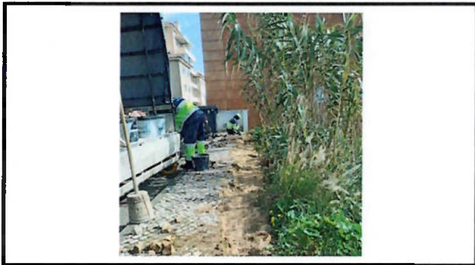
Reparação de calçada
