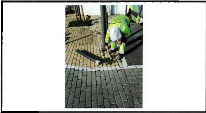
Recolocação de Pilarete
