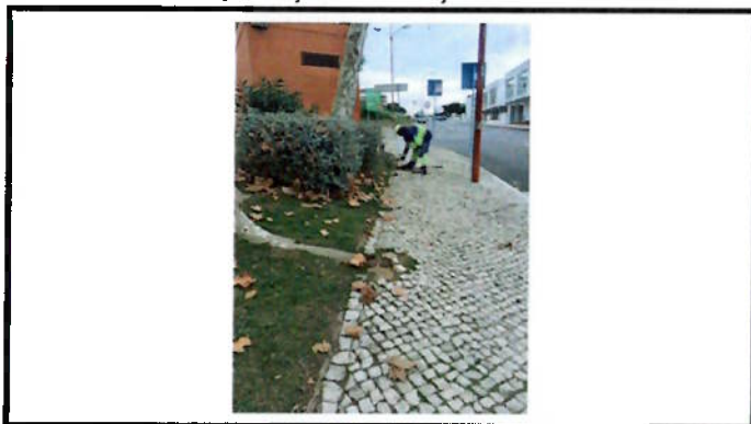
Reparação de calçada
