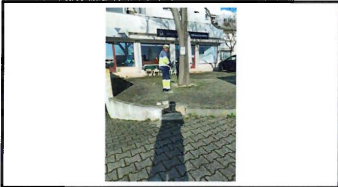
Reparação de lancil
