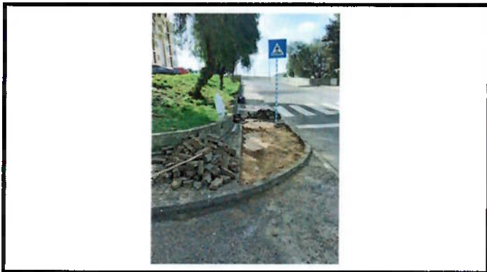
Reparação de calçada
