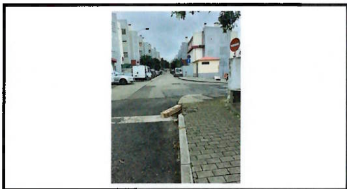
Reparação de lancil
