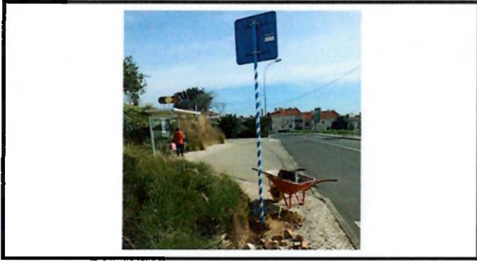
Colocação de sinalização vertical
