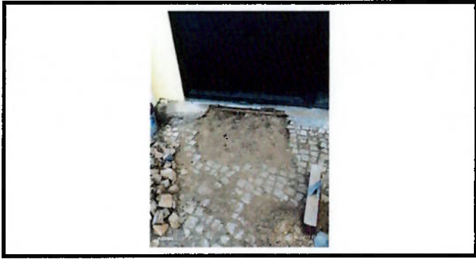
Reparação de calçada
