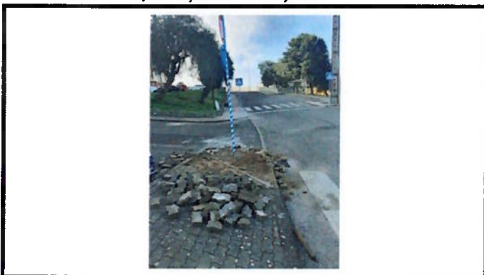
Reparação de calçada
