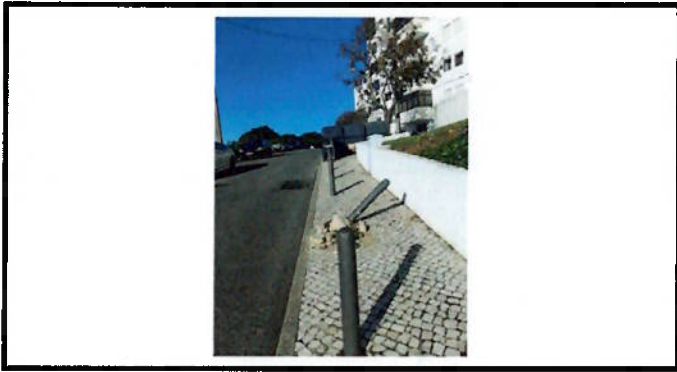
Recolocação de pilarete
