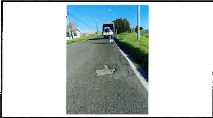
Reparação de pavimento
