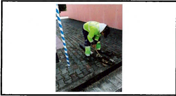
Recolocação de pilarete
