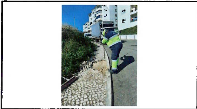
Reparação de calçada
