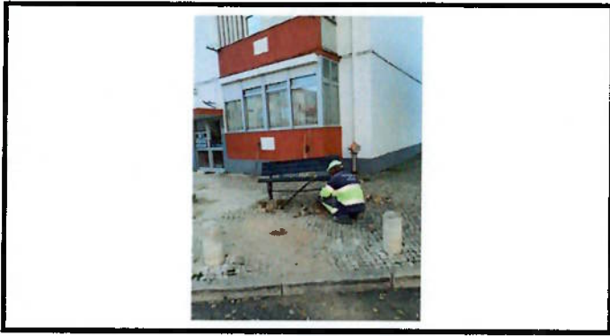
Reparação de calçada
