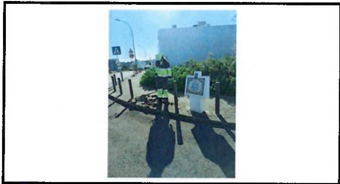
Reparação de calçada e recolocação de pilarete
