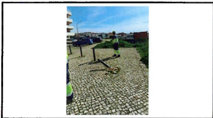
Recolocação de pilarete
