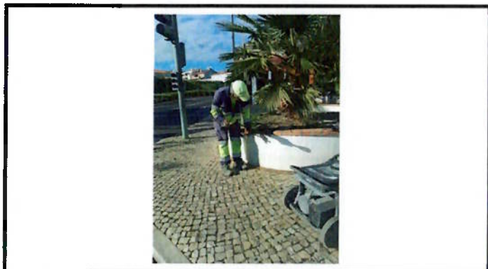
Reparação de murete
