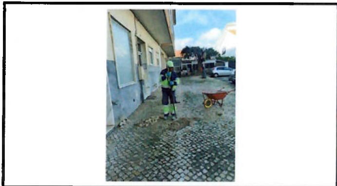
Reparação de calçada
