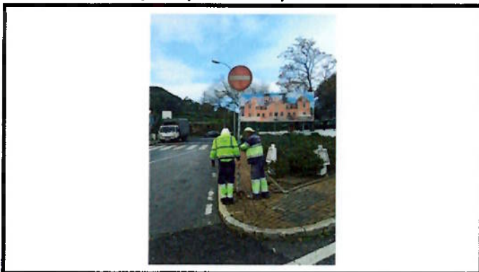
Substituição de sinalização vertical
