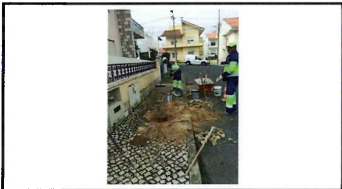
Reparação de calçada
