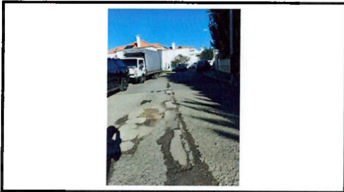
Reparação de pavimento
