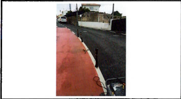
Recolocação de balizadores
