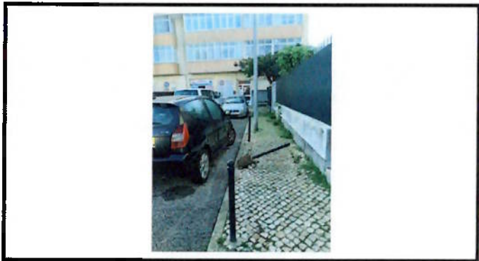
Recolocação de pilarete
