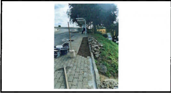
Reparação de calçada
