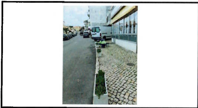
Colocação de floreiras
