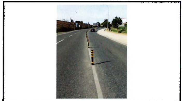
Estrada de Paço de Arcos
