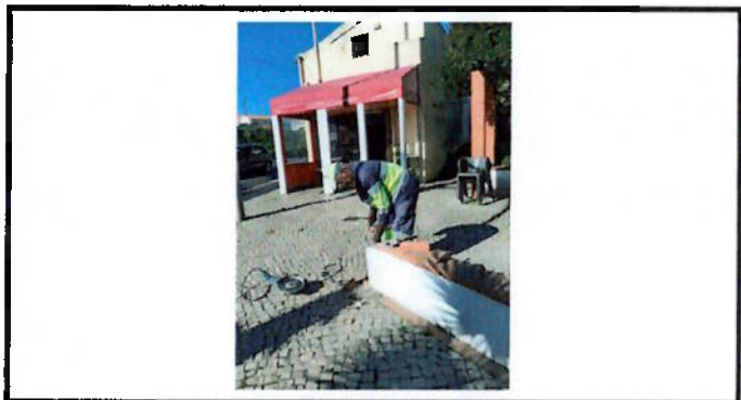
Arranjo de murete
