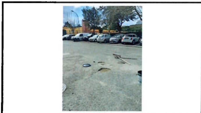
Recolocação de pavimento
