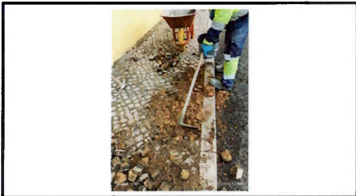
Reparação de calçada
