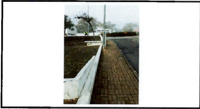
Pintura de Muretes
