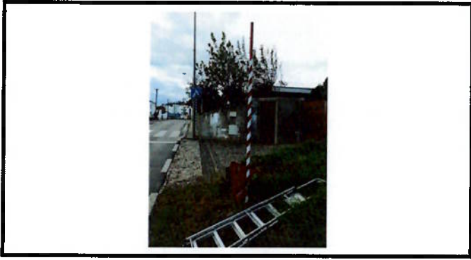
Substituição de Sinalização vertical
