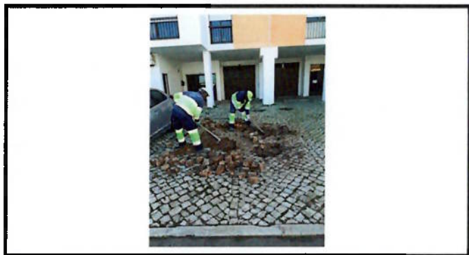
Reparação de calçada
