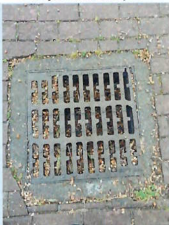
Limpeza de Sarjeta
