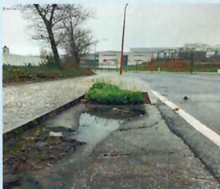
Limpeza de Sarjeta
