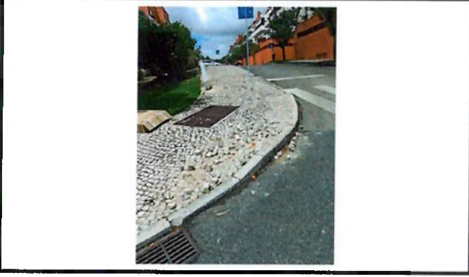
Reparação de calçada
