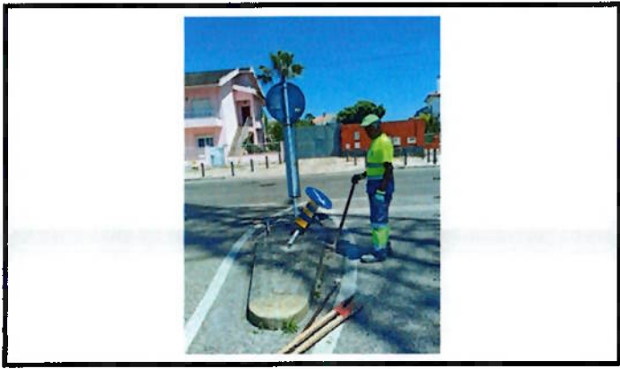
Recolocação Sinalização Vertical
