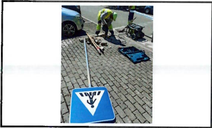
Recolocação de sinalização vertical
