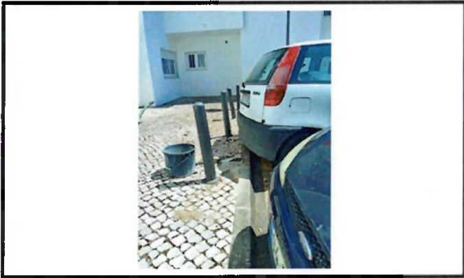
Reparação de calçada
