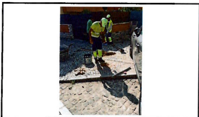
Colocação de pilaretes
