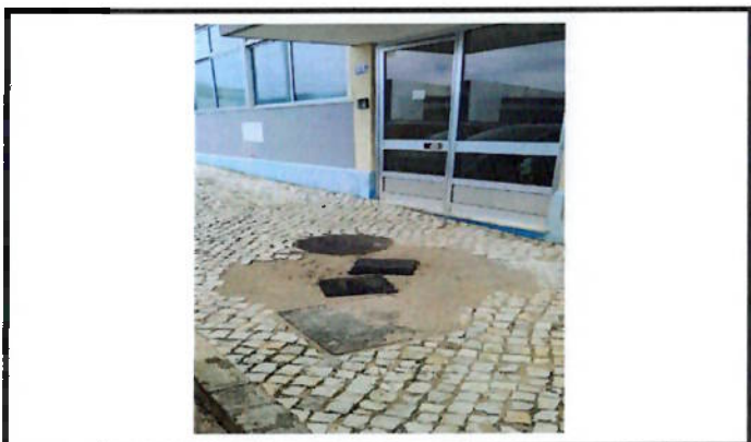
Reparação de calçada
