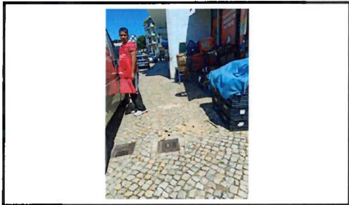
Reparação de calçada
