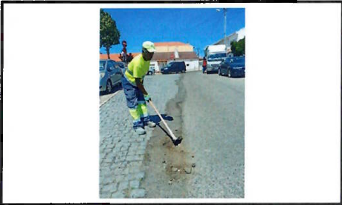
Reparação de pavimento
