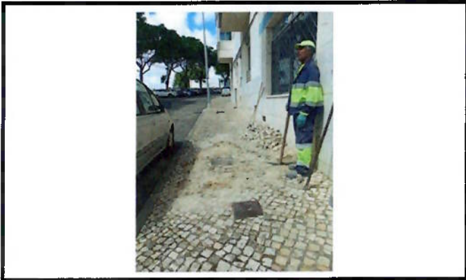
Reparação de calçada
