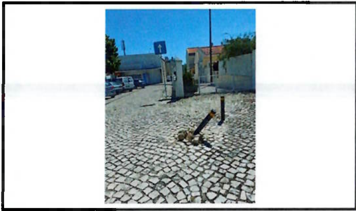
Reposição de pilarete e reparação de calçada
