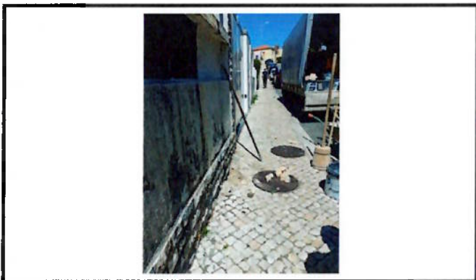
Reparação de calçada
