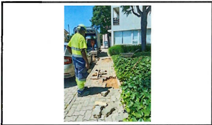
Reparação de calçada
