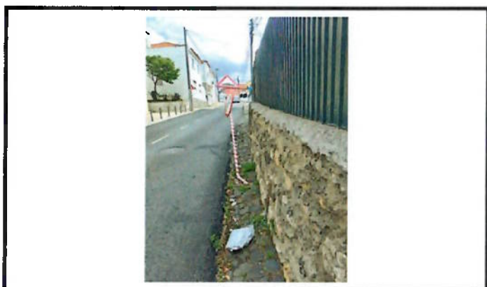
Substituição de sinalização vertical
