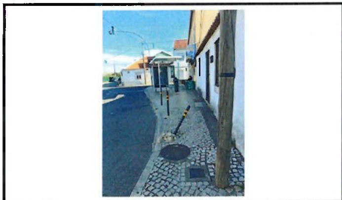
Recolocação de Pilarete
