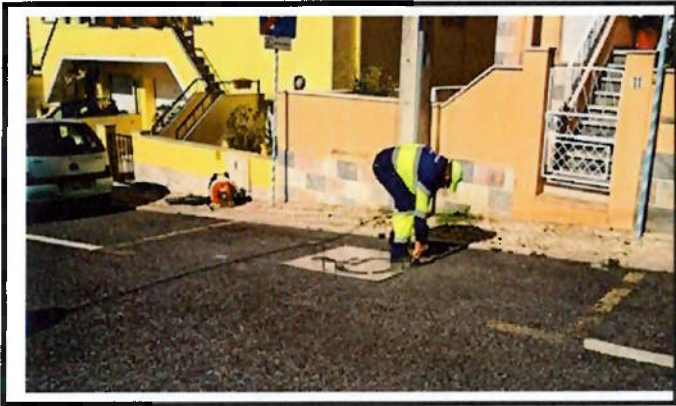
Pintura de sinalização horizontal
