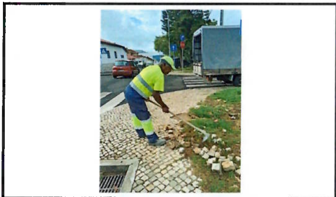
Reparação de calçada
