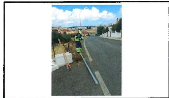
Substituição de sinalização vertical
