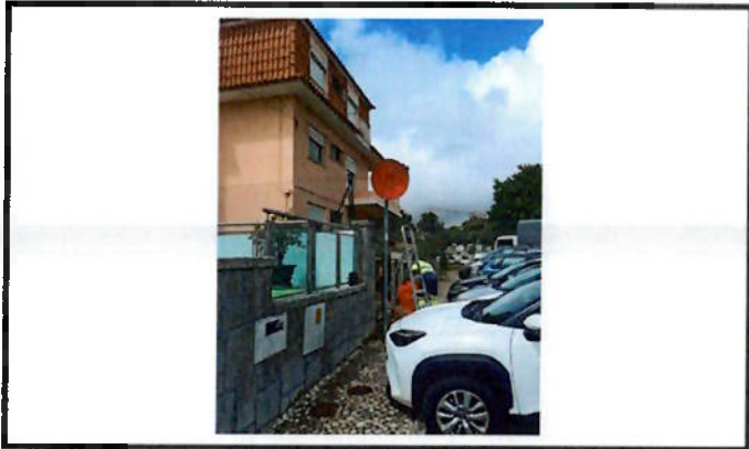
Substituição de sinalização vertical
