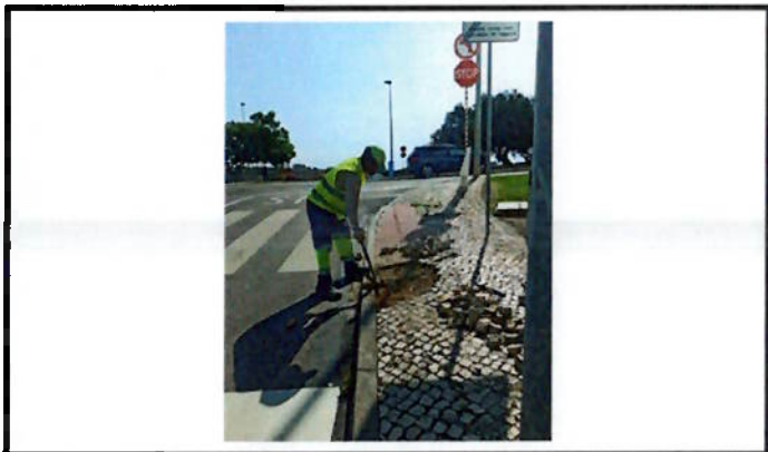
Reparação de Calçada
