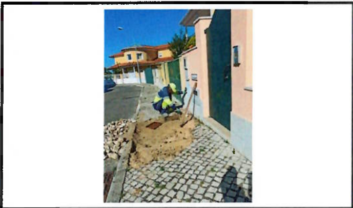
Reparação de calçada
