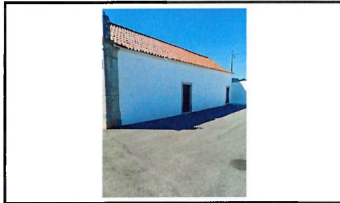
Estrada de Talaíde (recinto da igreja)
