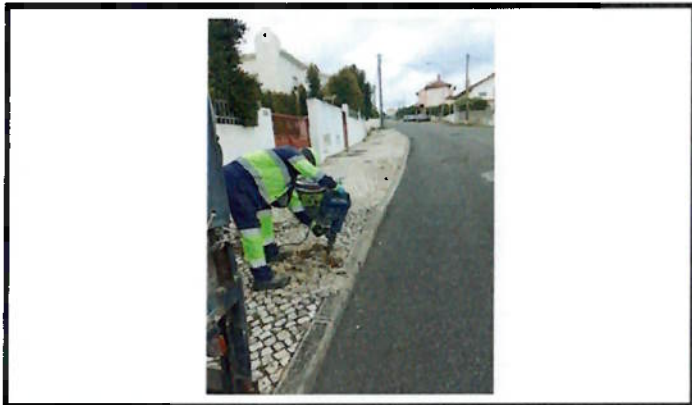
Reparação de calçada
