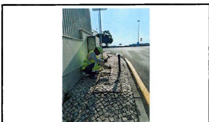
Reparação de calçada
