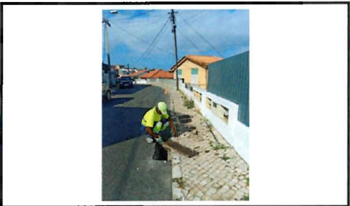
Reparação de caixa de sarjeta
