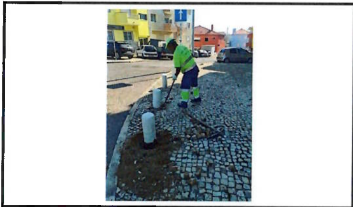
Substituição de pilaretes
