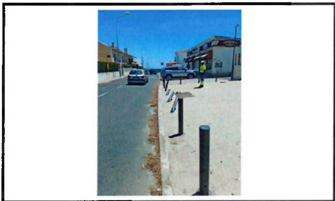
Recolocação de pilaretes
