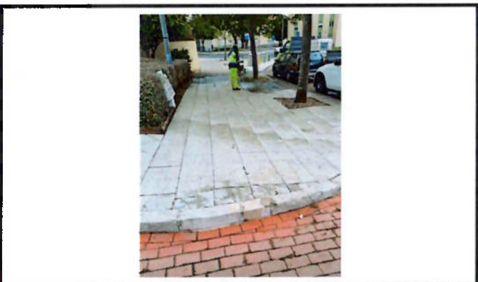
Lavagem de lajetas
