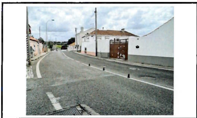
Colocação de balizadores
