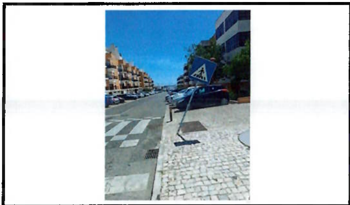
Substituição de sinalização vertical
