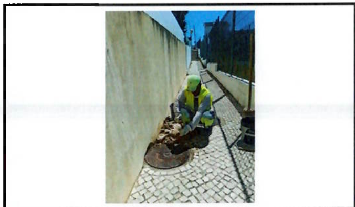
Reparação de Calçada
