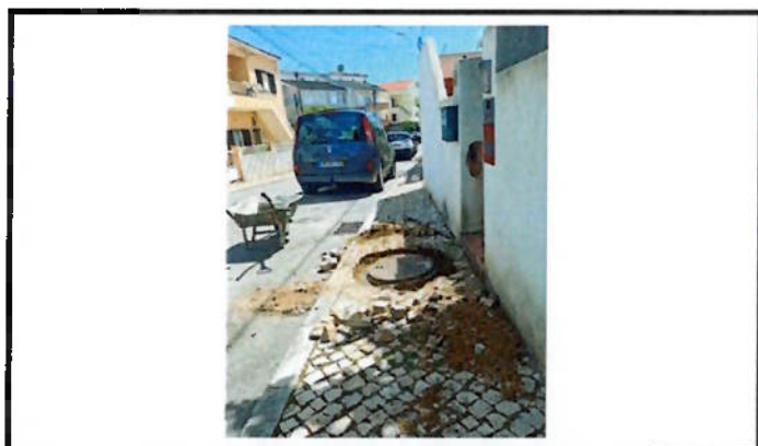
Reparação de calçada
