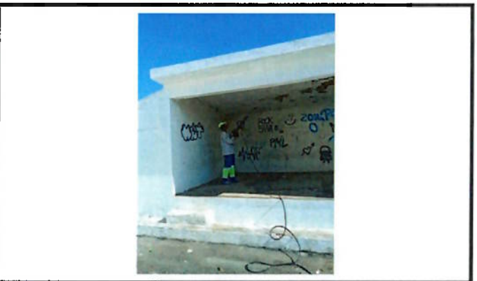
Lavagem, reparação e pintura
