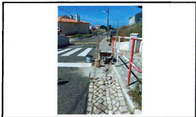
Reparação de calçada
