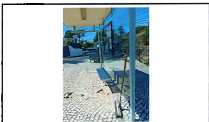
Reparação de calçada
