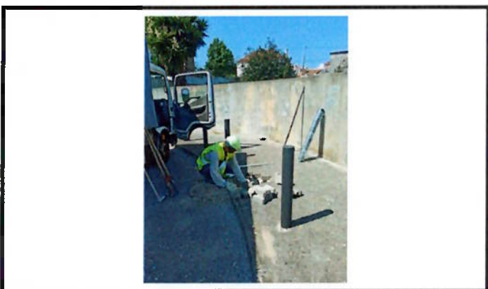
Colocação de Pilarete
