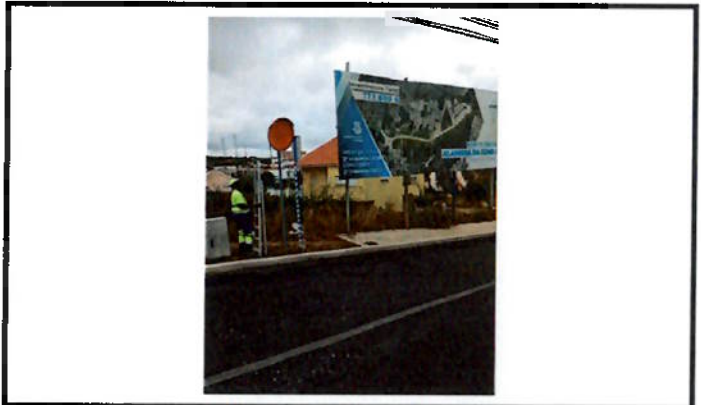
Substituição sinalização vertical
