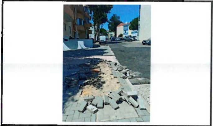
Reparação de calçada
