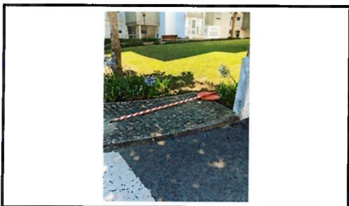
Recolocação de sinalização vertical
