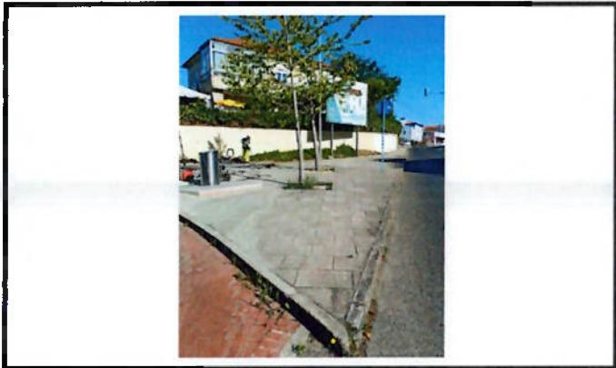
Lavagem de lajetas
