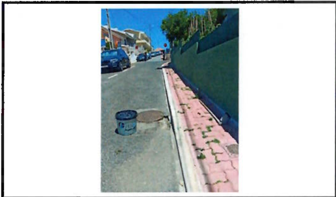
Reparação de pavimento
