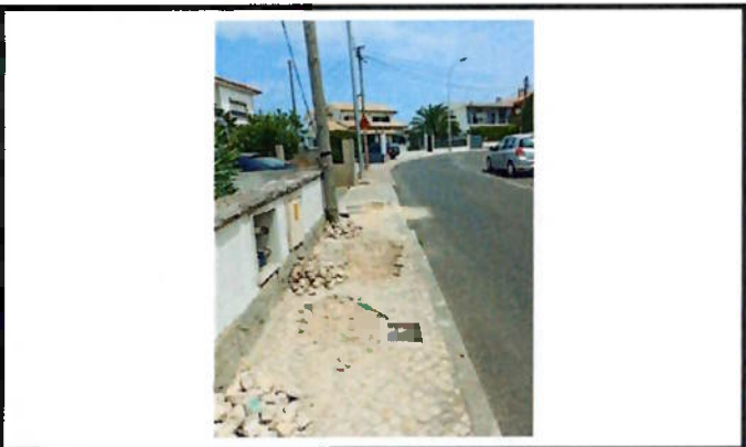
Reparação de calçada
