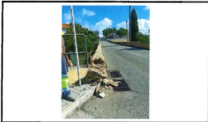
Reparação de muro
