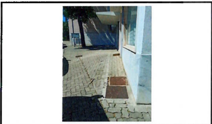
Reparação de calçada
