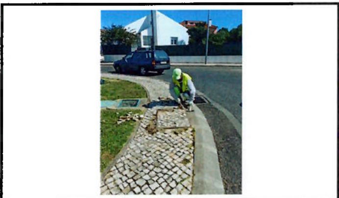
Reparação de calçada
