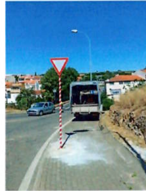
Estrada da Ribeira da Lage
