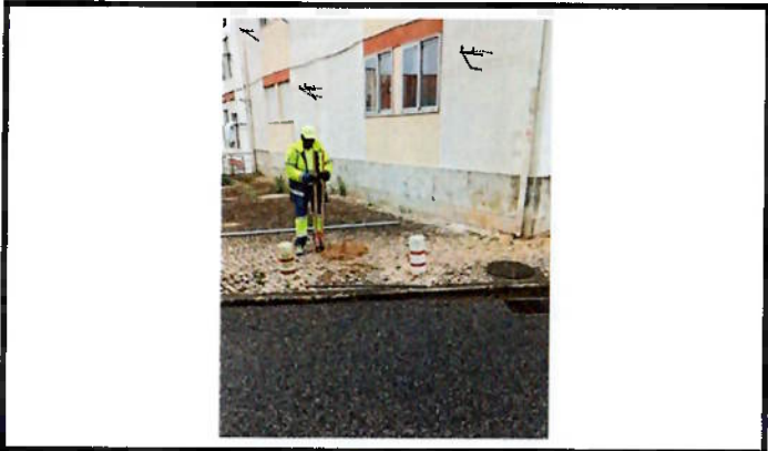
Colocação de sinalização vertical
