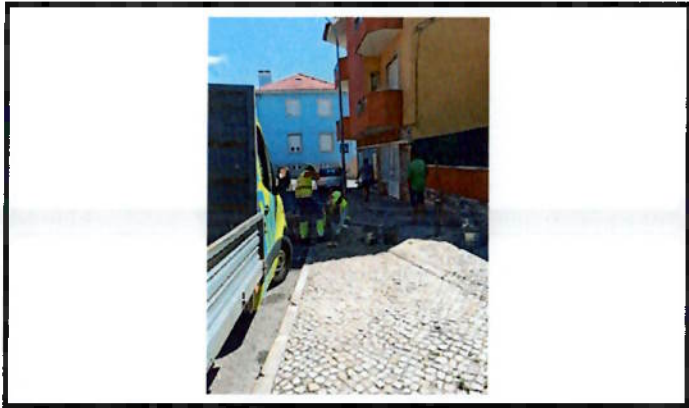
Colocação de pilaretes
