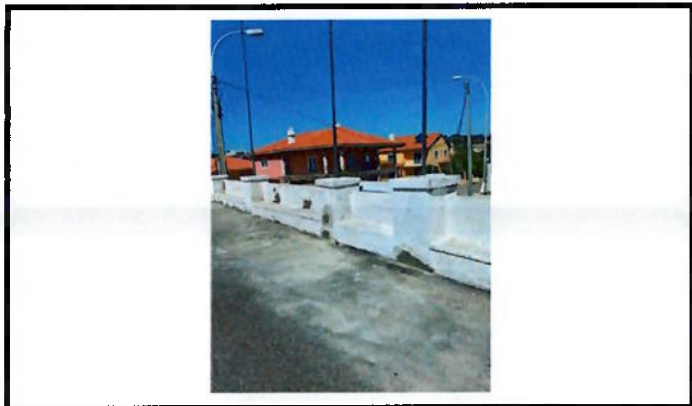
Lavagem, reparação e pintura
