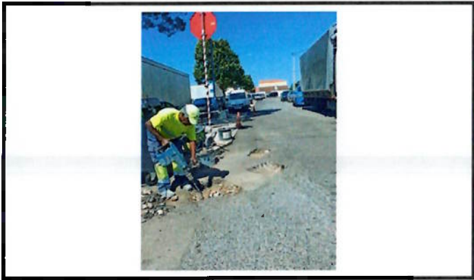
Reparação de pavimento
