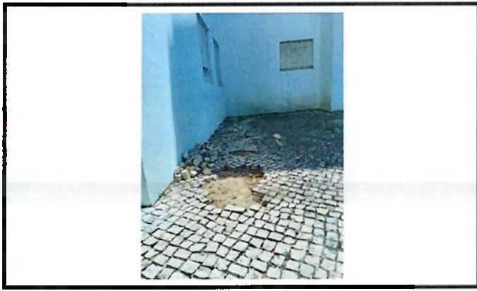
Reparação de calçada
