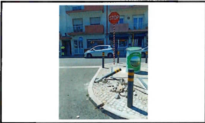
Reposição de pilarete e reparação de calçada
