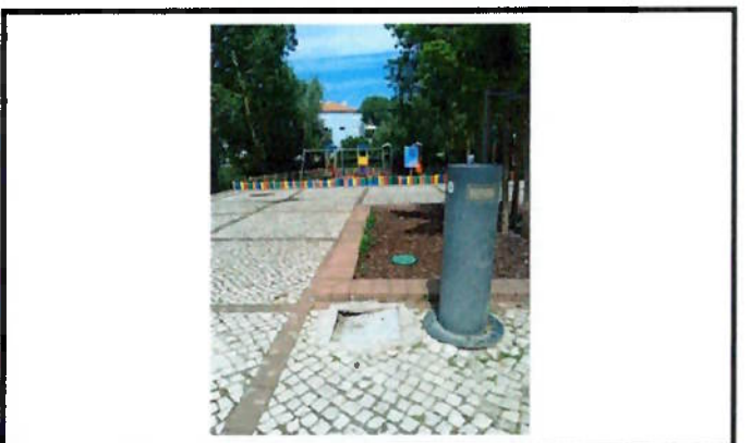
Reparação de caixa de água
