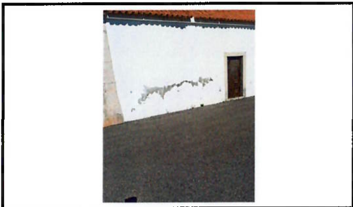
Lavagem, reparação e pintura
