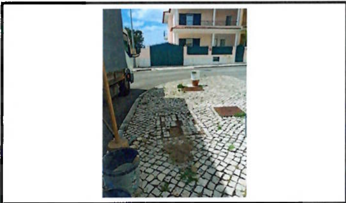
Reparação de calçada
