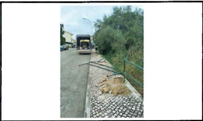
Reparação de gradeamento
