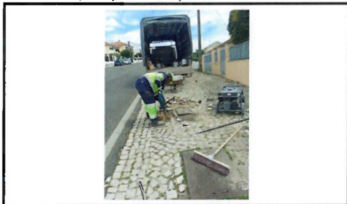
Reparação de calçada
