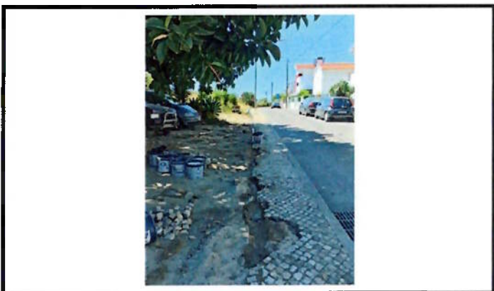
Reparação de calçada
