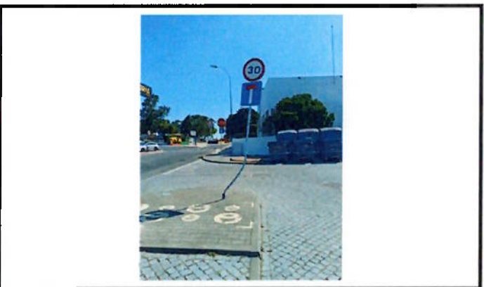
Substituição de Sinalização Vertical
