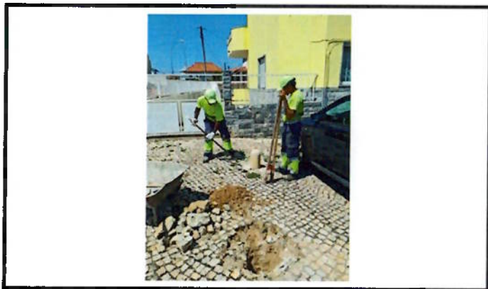
Substituição de pilaretes
