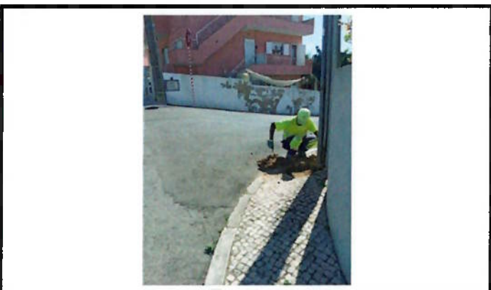
Reparação de calçada
