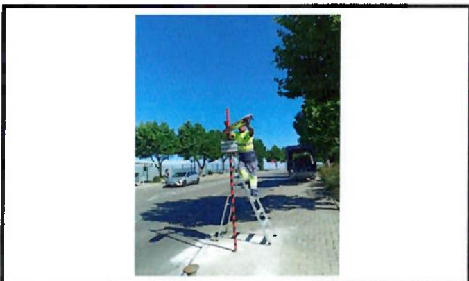
Substituição de sinalização vertical
