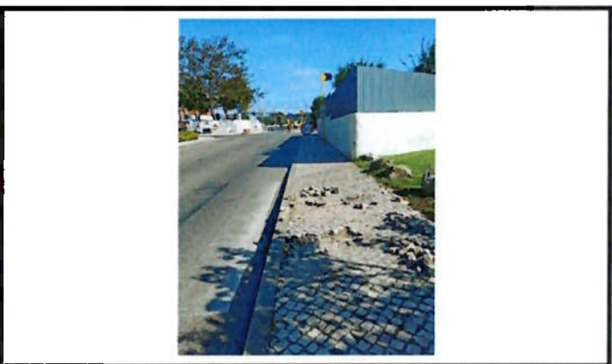
Reparação de calçada
