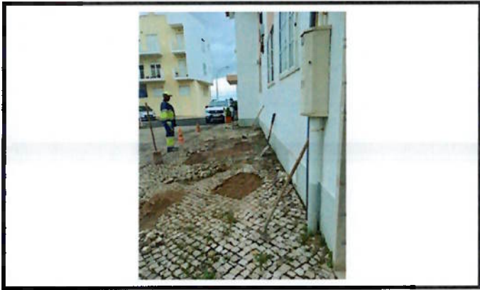
Reparação de calçada
