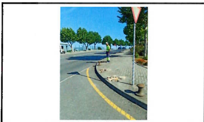
Reparação de calçada
