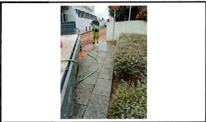
Lavagem de lajetas
