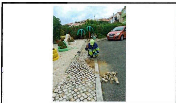
Reparação de calçada
