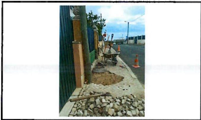
Reparação de calçada
