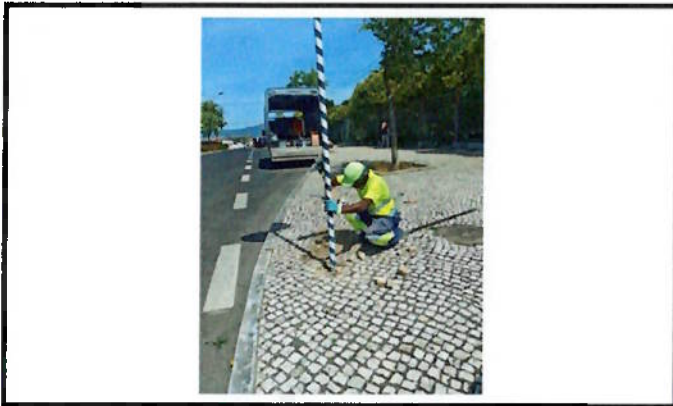
Reparação de calçada
