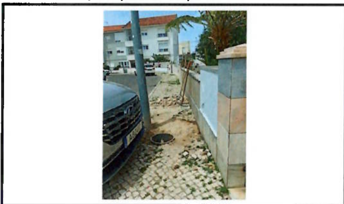
Reparação de calçada e levantamento de caixa
