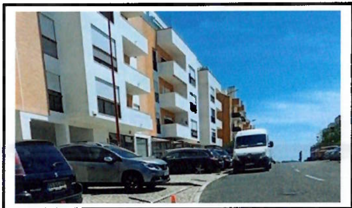
Reparação de lancil
