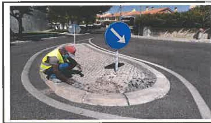
Reparação de calçada
