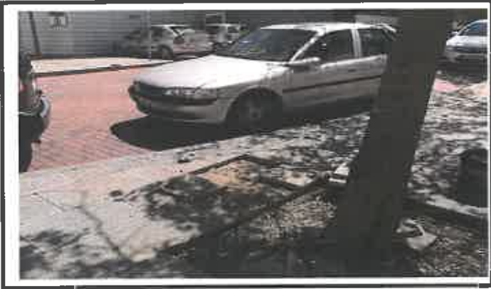
Levantamento e reassentamento de lajetas
