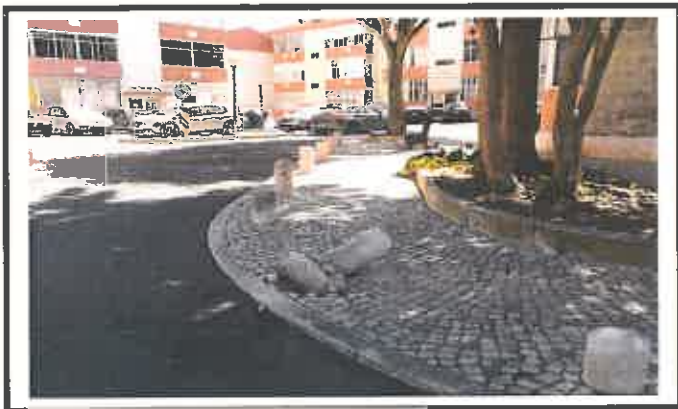
Reassentamento de pilarete de pedra
