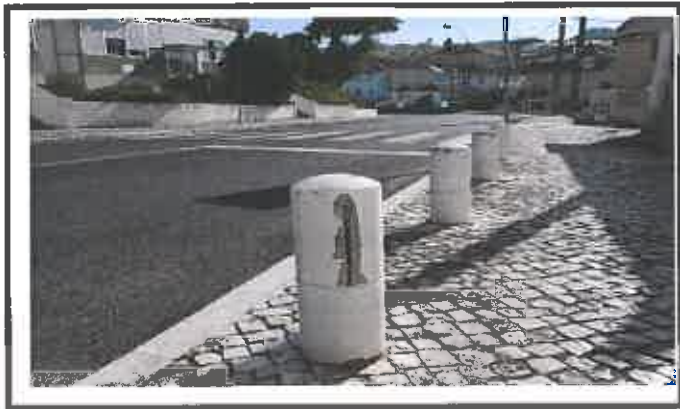
Reparação e pintura de pilaretes
