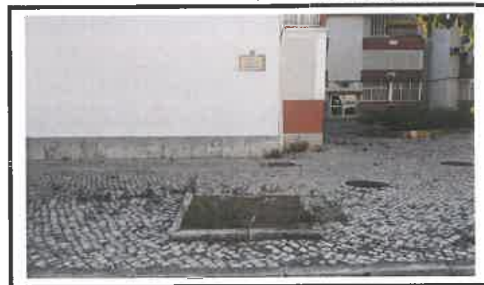
Eliminação de caldeira de árvores e execução de calçada
