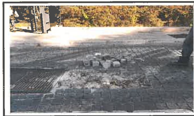
Reparação de calçada em paralelos de granito
