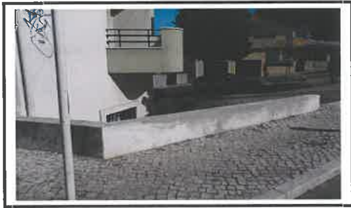
Pintura de muros
