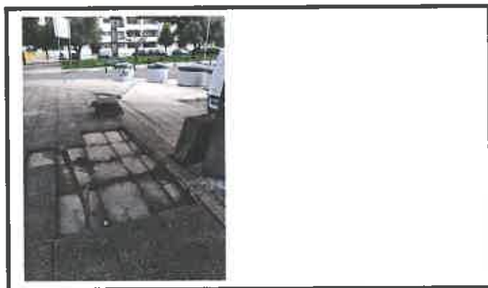
Levantamento e reassentamento de lancis
