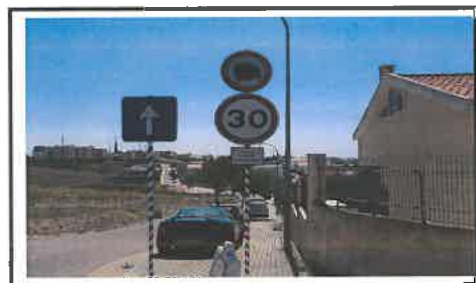
Substituição de sinal de trânsito
