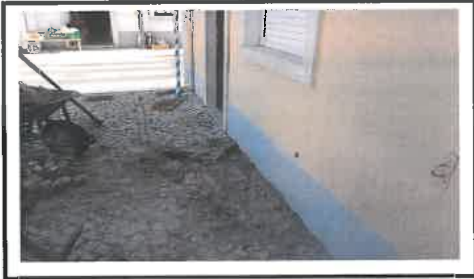
Reparação de calçada
