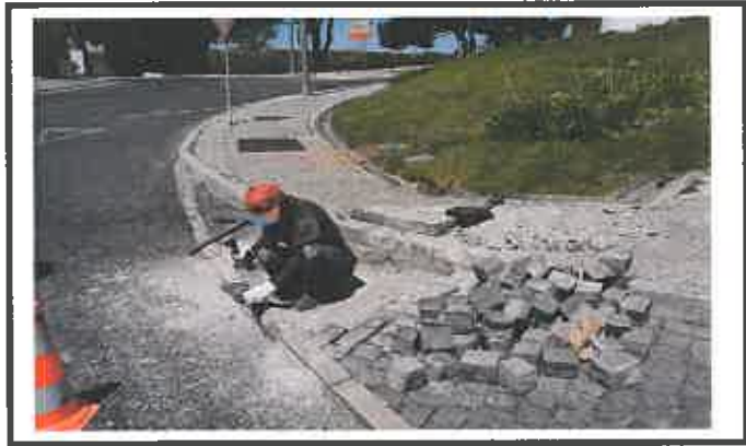
Reparação de calçada em paralelos de granito
