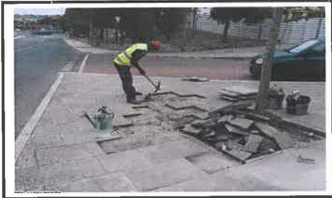
Levantamento e reassentamento de lajetas
