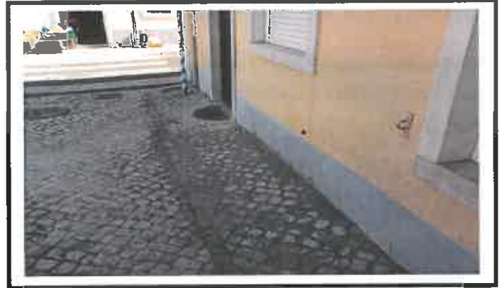
Rua Conde de Rio Maior entre 24 e 24A
