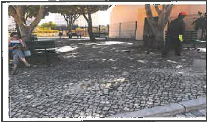
Reassentamento de pilarete e calçada
