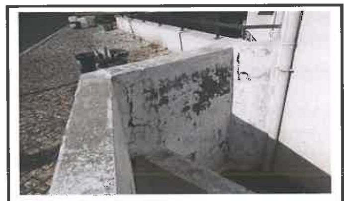
Rematar muros e pintura dos mesmos
