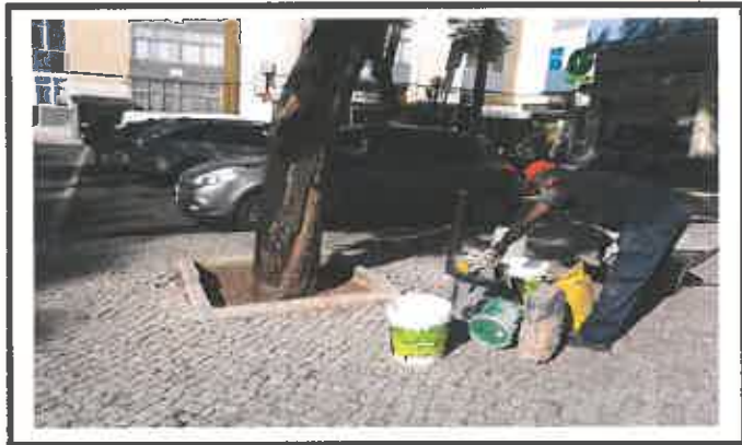
Rematar lancis de caldeiras
