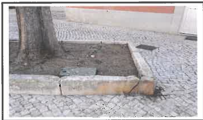
Rematar lancis de caldeiras
