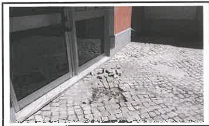
Reparação de calçada
