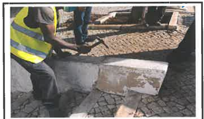
Rematar muros e pintura dos mesmos
