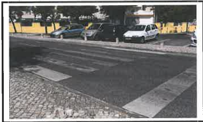
Reparação de calçada
