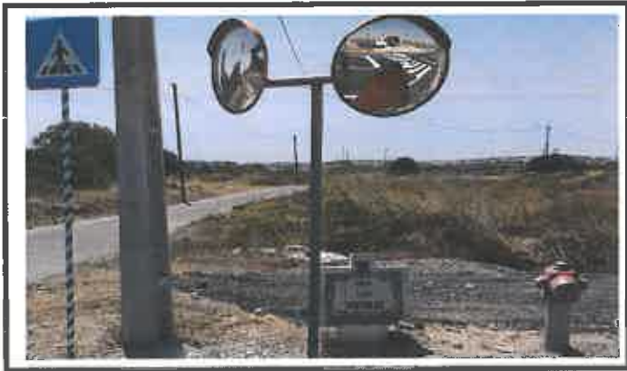
Substituição de 2 espelhos parabólicos
