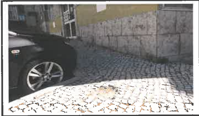
Reparação de pavimento calçada
