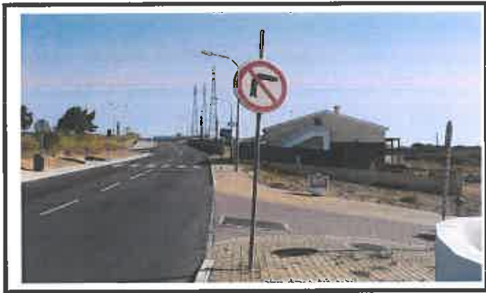
Substituição de prumo
