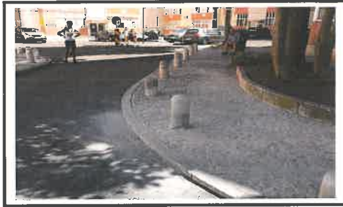
Entrada da Praceta Aldeia do Meio
