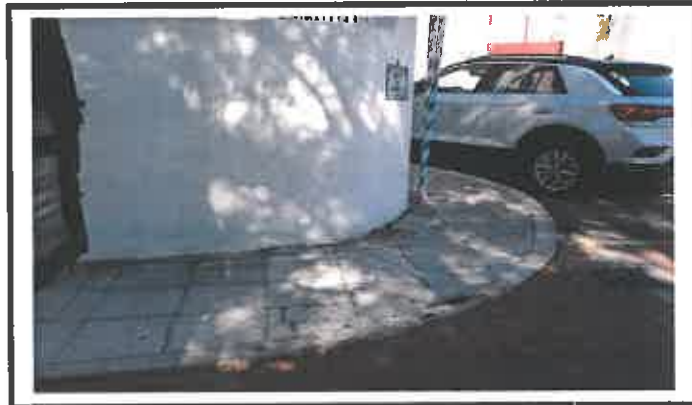
Assentamento de pilarete
