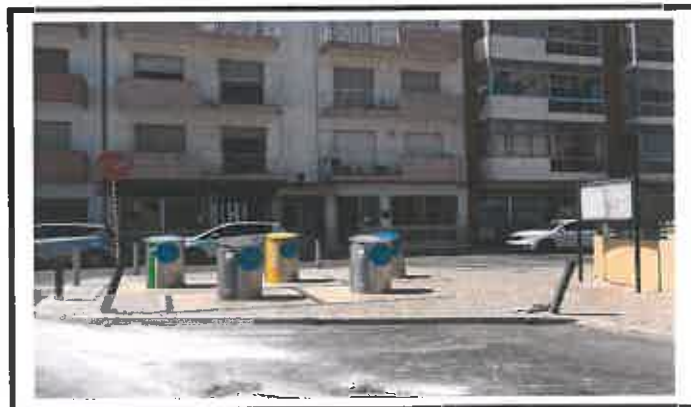
Reassentamento de dois pilaretes e calçada
