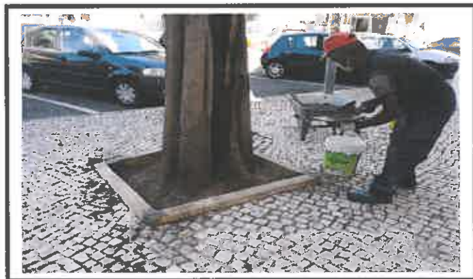
Rematar lancis de caldeiras
