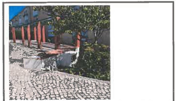
Estrada de Paço de Arcos
