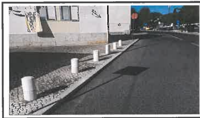
Reparação e pintura de pilaretes
