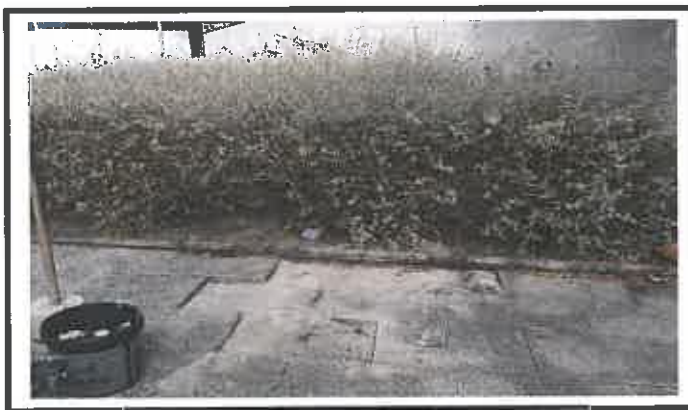
Levantamento e reassentamento de lajetas
