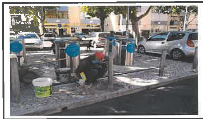
Reassentamento de pilarete metálico
