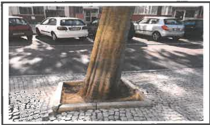
Rematar lancis de caldeiras
