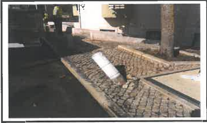
Reassentamento de pilarete
