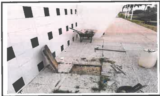
Levantamento e reassentamento de lancis
