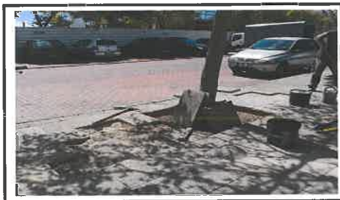
Levantamento e reassentamento de lajetas
