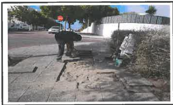
Levantamento e reassentamento de lajetas
