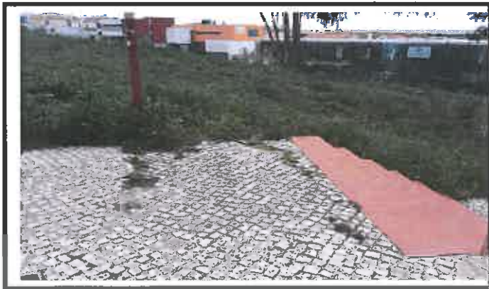
Reparação de calçada
