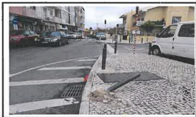
Reassentamento de pilarete e calçada
