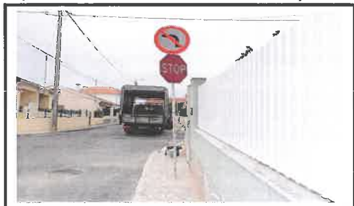
Aprumar sinal de trânsito e reassentar calçada
