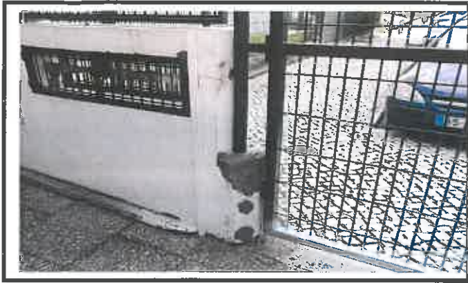
Reparação de muro e pintura de portões
