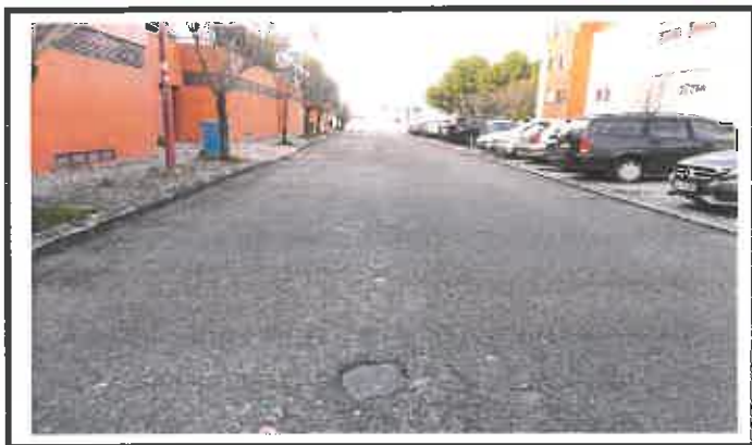
Reparação de pavimento betuminoso
