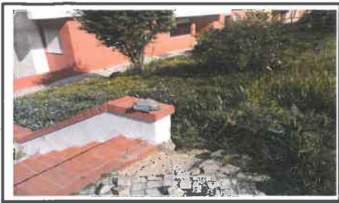
Reparação de calçada
