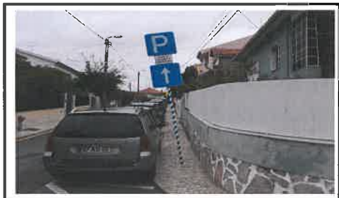
Aprumar sinal de trânsito e reassentar calçada
