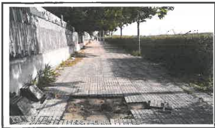
Reassentamento de lajetas
