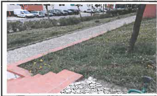
Reparação de calçada
