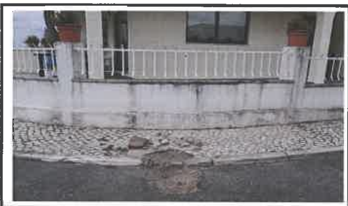
Reparação de calçada, lancil e pavimento betuminoso
