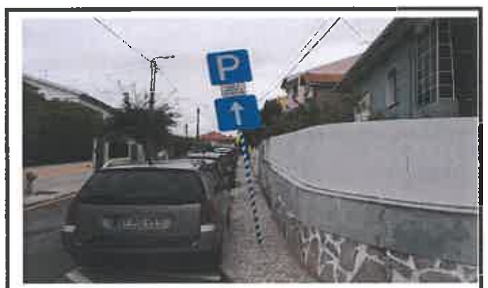
Aprumar sinal de trânsito e reassentar calçada
