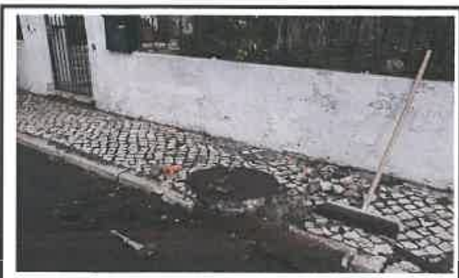
Reparação de lancil, calçada e pavimento betuminoso
