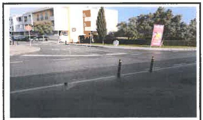
Recolocação de pilarete
