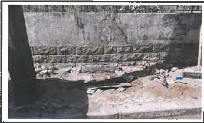
Reparação de calçada
