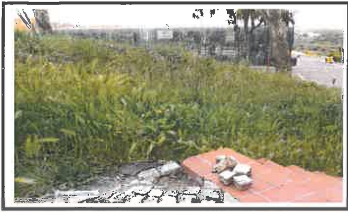
Reparação de calçada
