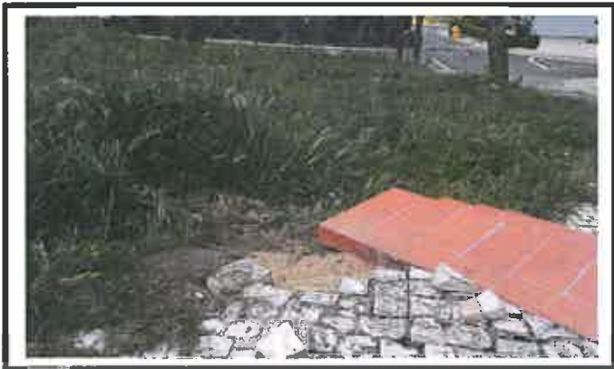
Reparação de calçada
