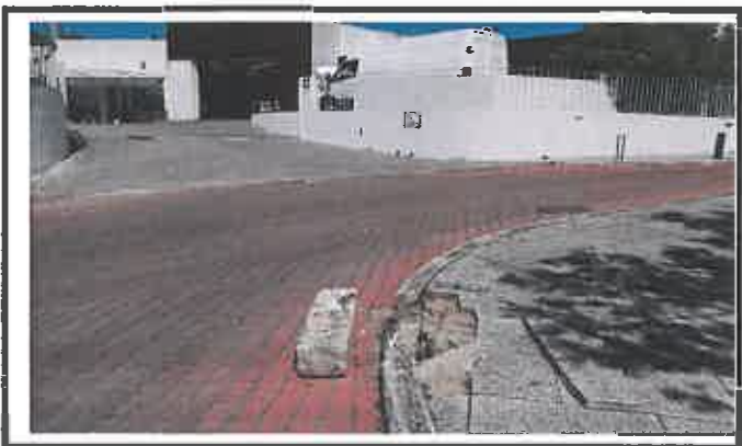
Reparação de lancil e lajetas
