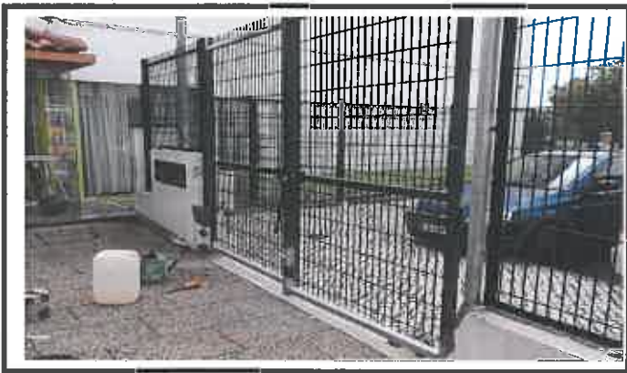
Reparação de muro e pintura de portões
