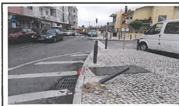
Reassentamento de pilarete e calçada
