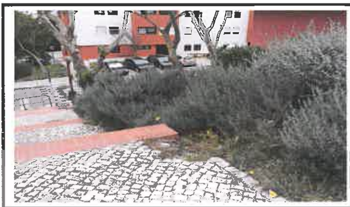
Reparação de calçada
