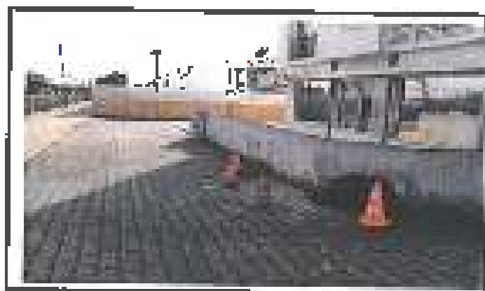
Reparação de pavimento pavé
