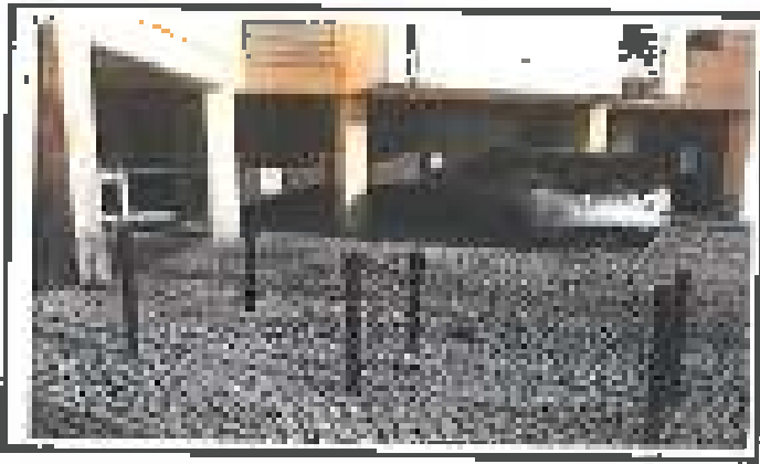
Lixar e pintar pilarete metálicos
