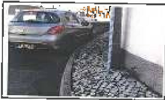
Reparação de calçada
