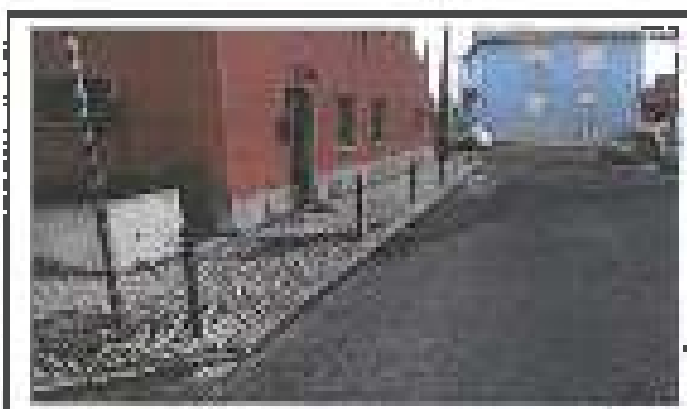
Limpeza e pintura de pilarete
