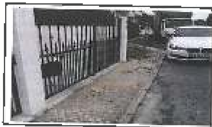
Rua Marques de Pombal frente 6A
